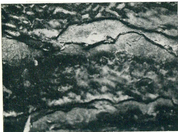
Figura 14.—En algunas zonas del Palacio Ferrera se observan, en sus areniscas, patinas de ennegrecimiento, costras, y desplazamientos más o menos sobreimpuestas, tal como muestra la fotografía.
