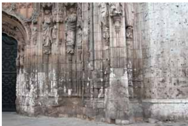
Figura 7. Diferencias en la alteración de la piedra (caliza del Páramo) con la altura, en la iglesia de San Pablo (Valladolid).
