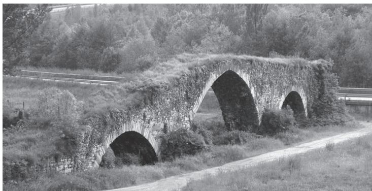
Figura 3. Puente Viejo de Olloniego, hoy sin agua, como consecuencia de un cambio en la localización del lecho fluvial del río Nalón
