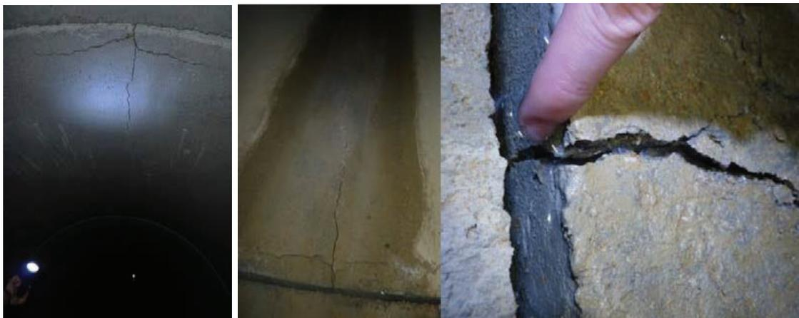
Se realizó una simulación numérica de la solución proyectada en el estado actual, llegándose a la conclusión de que la estructura era estable incluso en estado fisurado.
