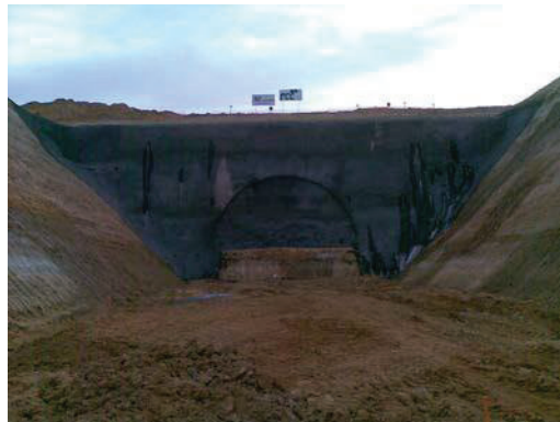
Figura 3. Frente de ataque para el inicio de la construcción del túnel
