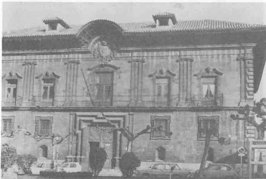
Lam. 12. Fachada a la «Plaza de la Fortaleza», hoy Porlier, del palacio de Oviedo.
