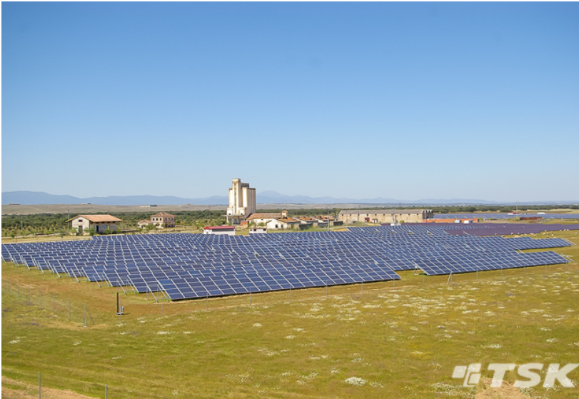
Figura 5.34. Vista de pájaro de la planta fotovoltaica de Hinojal (fuente [102]). Con un total de 32 inversores tiene una capacidad de producción de hasta 4 MW.
