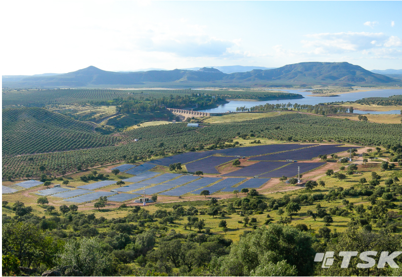
Figura 5.35. Vista de pájaro de la planta fotovoltaica de Iruela (fuente [102]). Construida en un terreno escarpado y con mucha heterogeneidad de marcas, esta planta puede producir hasta 3,5 MW.
