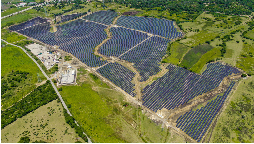
Figura 5.14. Vista de pájaro de la planta fotovoltaica Baní (fuente [102]). Ocupa un total de 80 hectáreas de terreno y tiene una capacidad de 50 MW.
