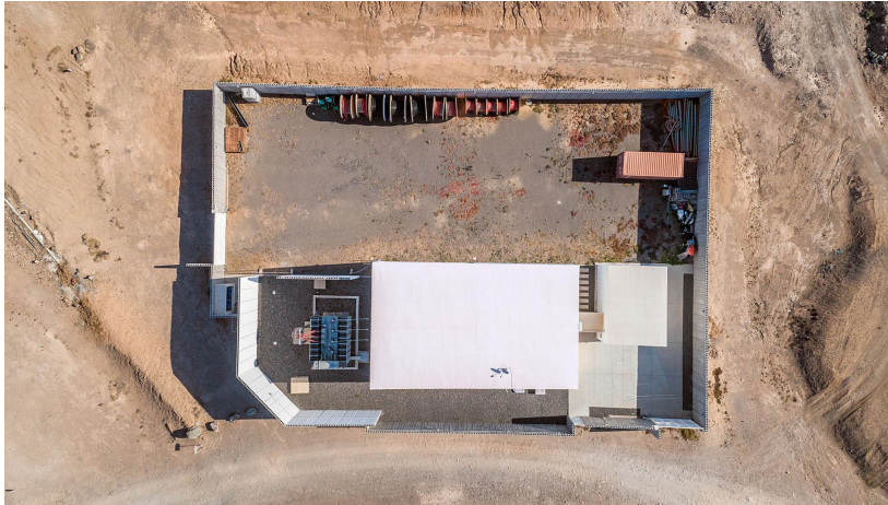
Figura 5.27. Vista de pájaro de la subestación de Granadilla (fuente [103]). La planta sirve de conexión para un complejo de generación renovable en la isla.
