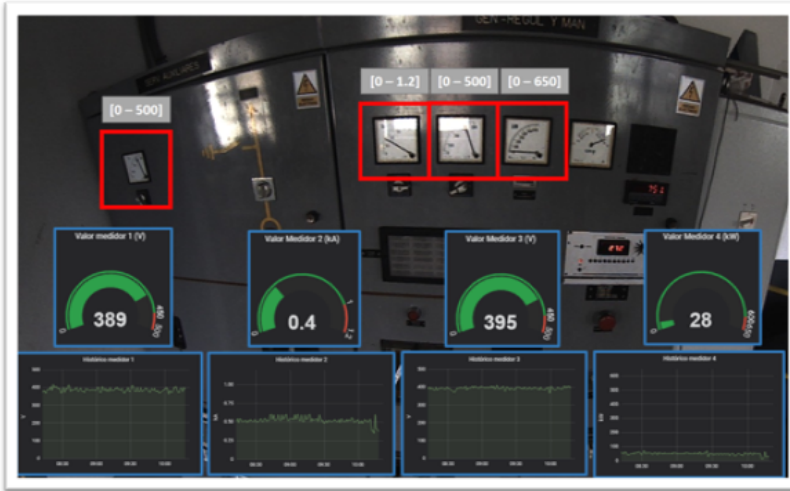
Figura 5.21. Ejemplo de panel analógico digitalizado de Fuentehermosa. El valor de los medidores se obtiene en dos etapas, primero se obtiene su ángulo y luego se aplica el rango del medidor.
