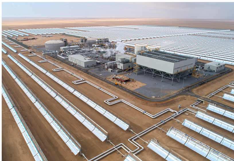
Figura 5.7. Vista de pájaro de la planta termosolar de Abdali (fuente [102]). Ocupa más de 200 hectáreas de terreno y tiene una capacidad de 50 MW.
