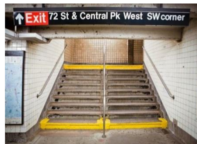
Fig. 95 Boca de metro de la calle Setenta y dos
