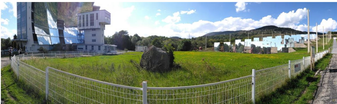
Figura 3. Felix Trombé, Horno Solar de Odeillo en construcción y horno solar en la actualidad.
