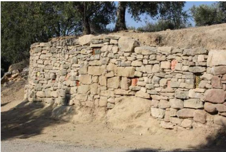
Trabajo de reconstrucción de una pared de piedra seca en la población de Sieso, 2023. En la técnica no se utilizan argamasas ni elementos que actúen como adhesivos entre las piedras. FIG. 384
