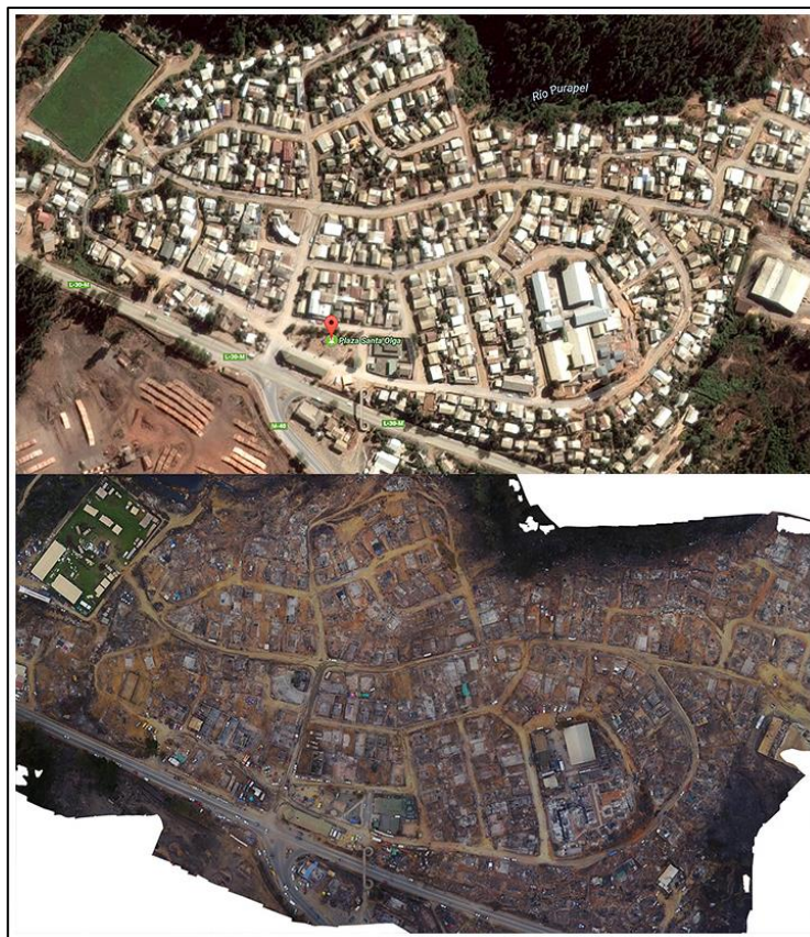
Ilustración 4. Santa Olga antes y después del Incendio Forestal Las Máquinas.
