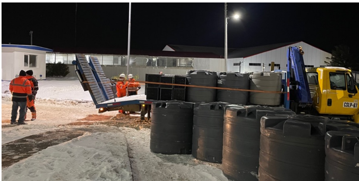
Figura 12. Trabajos para habilitar plan de abastecimiento alternativo por emergencia de bajas temperaturas en Punta Arenas. Invierno de 2024. (Fuente. Registro Personal)
