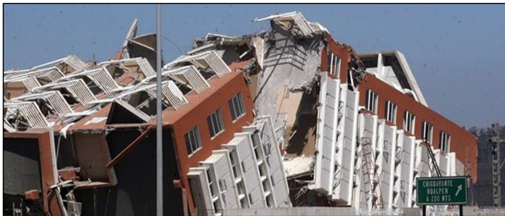
Fotografía N° 1, Edificio “Alto Río” – Concepción
