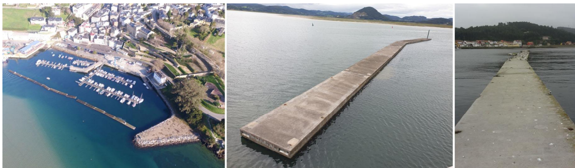
Figura 5. Pontones flotantes en los puertos deportivos de Figueras (Principado de Asturias), Santoña (Cantabria) y San Juan de la Arena (Principado de Asturias). Paneles izquierda, centro y derecha respectivamente.
