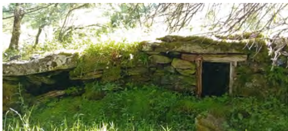
Fig. 66. A la bajada encontramos una curiosa construcción, las «ol.l.eras» (otseras en paschuezo) que servían para conservar fría la leche, neveras construidas con ingenio, materiales locales y alto coste energético personal
