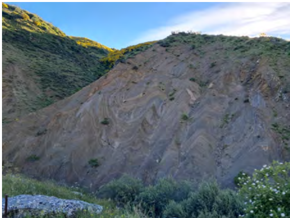
Fig. 53. Afloramiento de lutitas plegadas y acarcabadas, situado a la vera del río Pinos, que se encuentra bajando del puerto hacia el pueblo del mismo nombre por la caja de la carretera puerto de Pinos -Pinos
