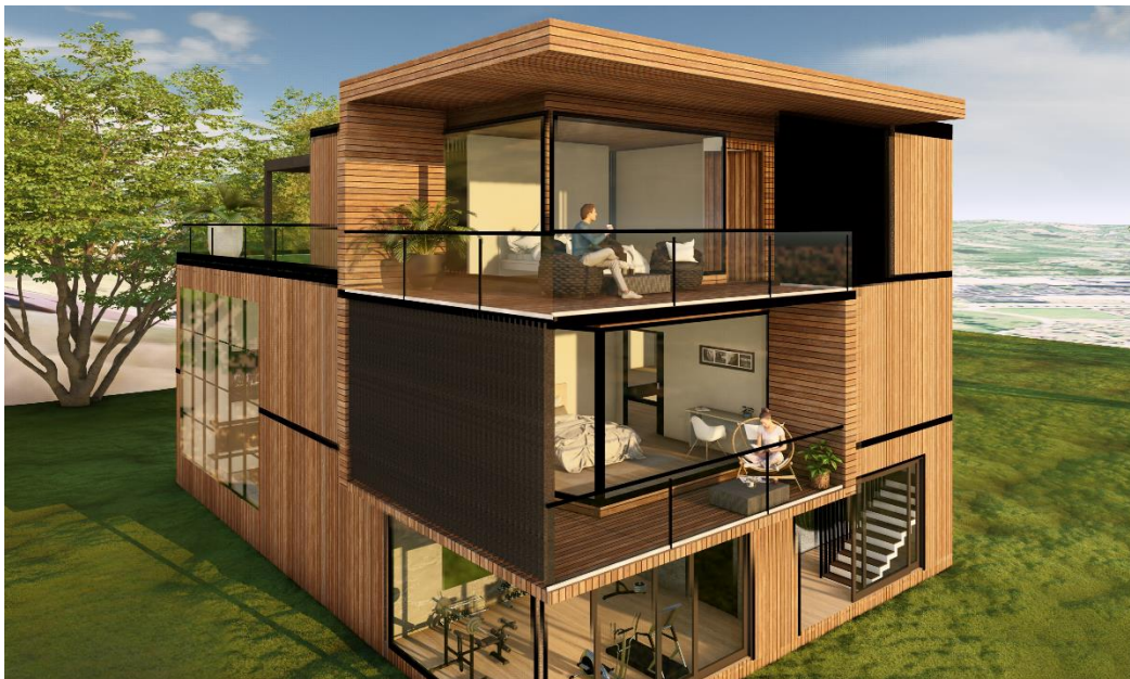
Ilustración 8: Fachada oeste de la vivienda. Fuente: Elaboración propia
