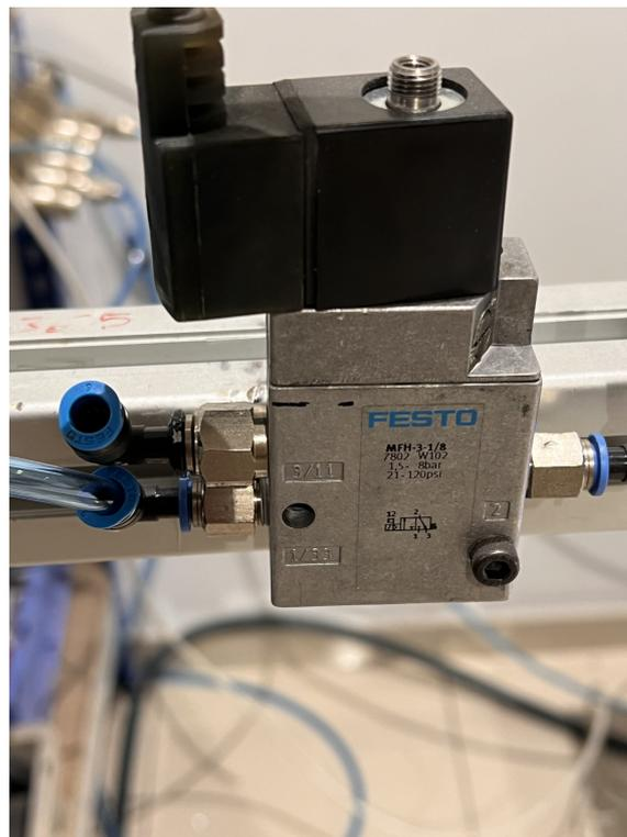
Figura 4.31: Electroválvula 3/2 monoestable usada para inyectar aire en la válvula de fluidos
