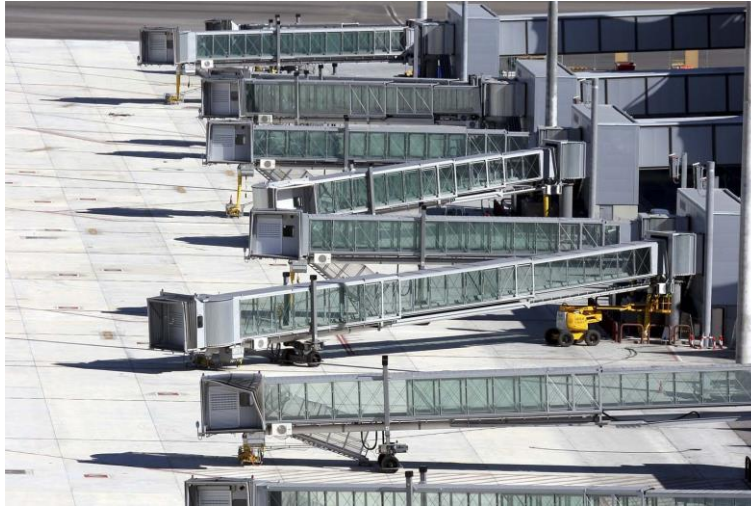
Figura 2.5. Pasarelas de embarque de pasajeros de TK Elevator con paredes compuestas por celosía de doble diagonal y suelo y techo de chapa delgada plegada en el Aeropuerto Adolfo Suárez Madrid-Barajas
