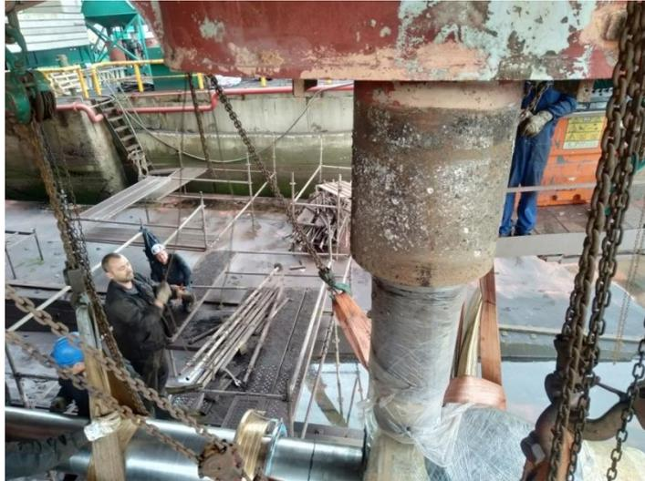
**Ilustración 27: Últimos pasos de la extracción de la hélice**
