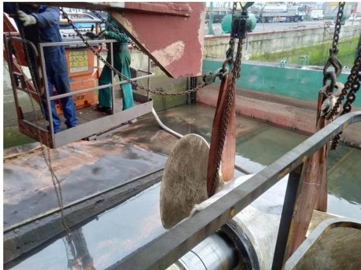
**Ilustración 37: Cambio de pesos del eje entre la grúa y los polipastos**
