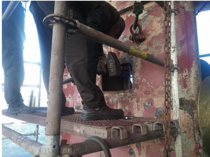
**Ilustración 15: Despegue de la tuerca gato con la llave de impacto y la maza**
