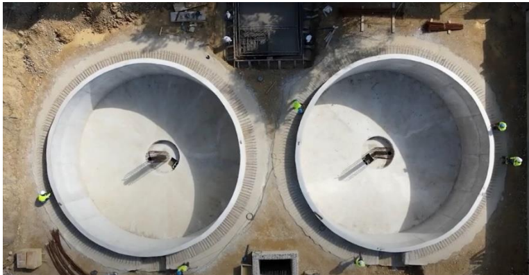
FIGURA 5.15- MODELADO DECANTADORES SECUNDARIOS
