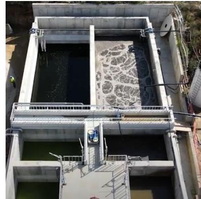
IMAGEN. 5.1. VISTA AEREA DEL REACTOR BIOLÓGICO CIMENTACION Y FUNCIONAMIENTO (ARCHIVO EDAR DE CALVIA MALLORCA)
