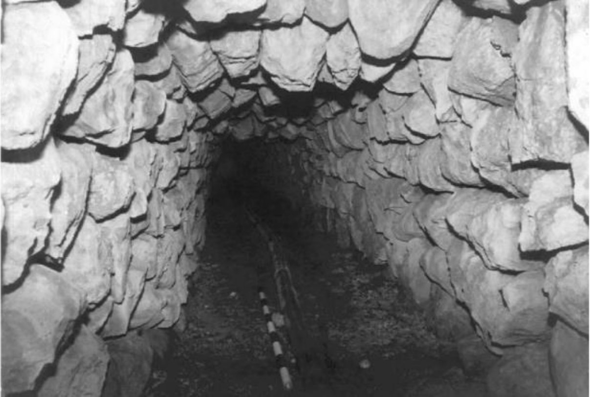
Figura 21. Imagen de la galería del Qanat de sa Font de Sort de Biniforani.
