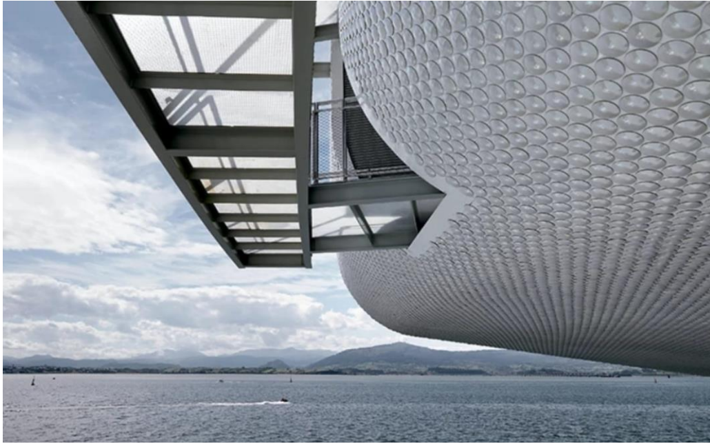
Figura 36. Detalles de la estructura en voladizo, observándose los acabados de escamas de cerámica además de parte de la pasarela mirador.
