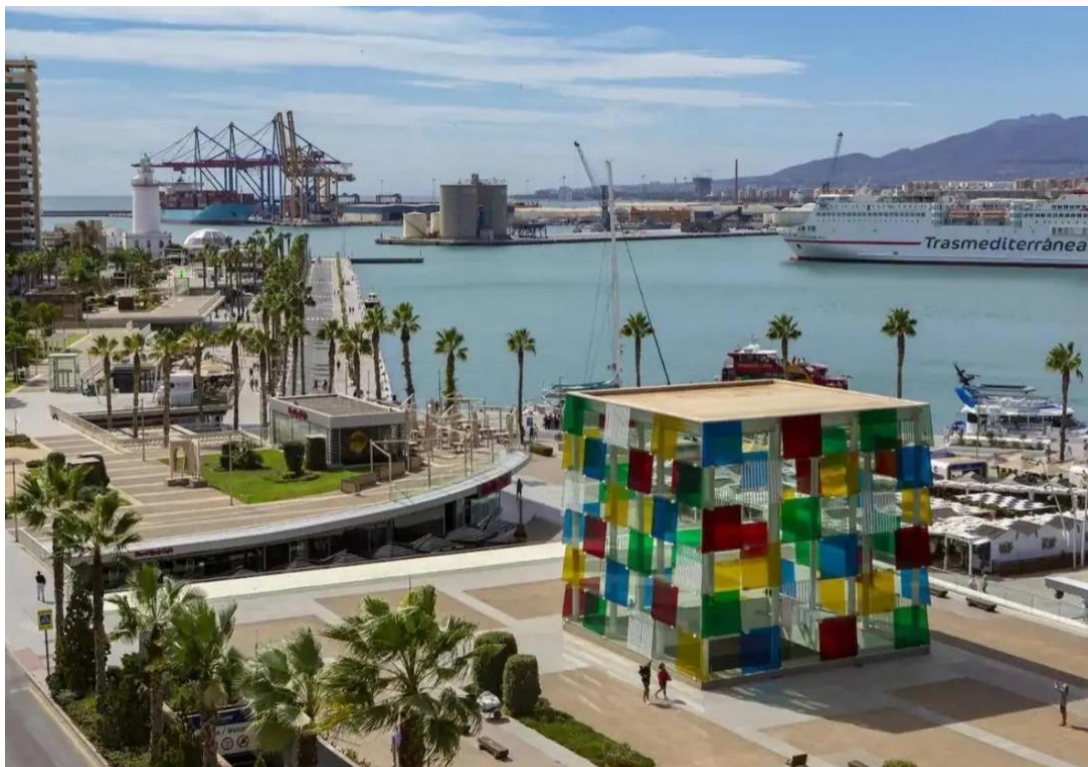
Figura 10. Vista general desde el lucernario del Centre Pompidou a La Farola.
