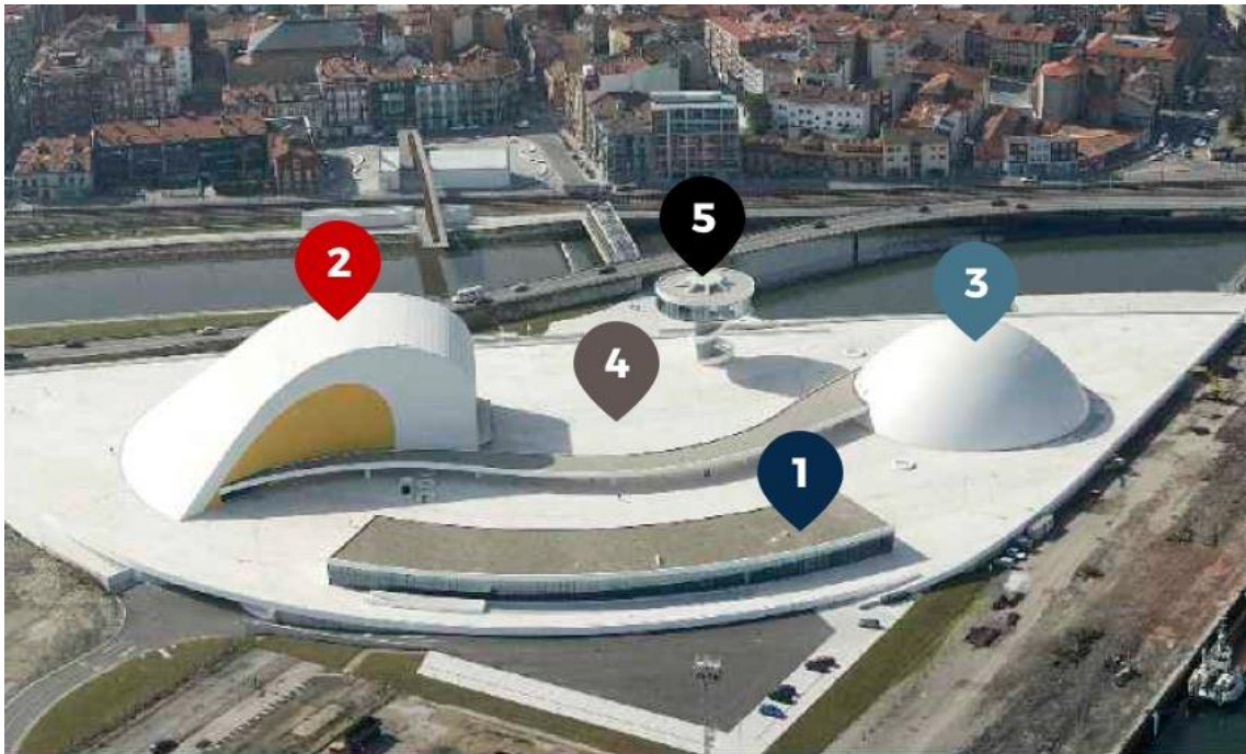
Figura 13. Espacios arquitectónicos del Centro Cultural Internacional Oscar Niemeyer. 1; Edificio de administración, 2; Auditorio, 3; Sala de exposiciones, 4; Marquesina de unión entre los dos espacios anteriores, 5; Torre mirador.
