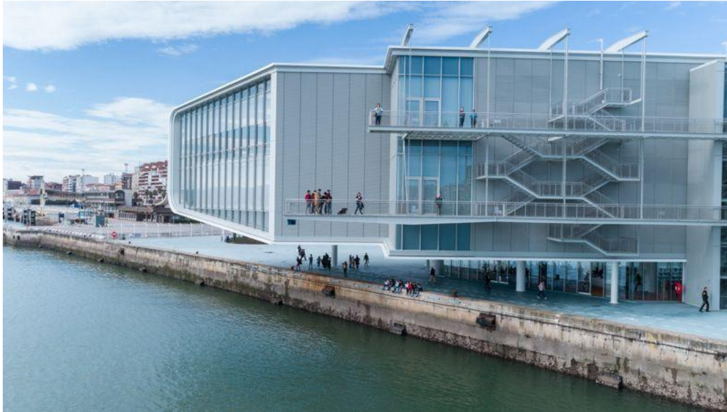
Figura 39. Vista lateral del entramado de escaleras y pasarelas, observándose su situación de mirador voladizo sobre el mar.
