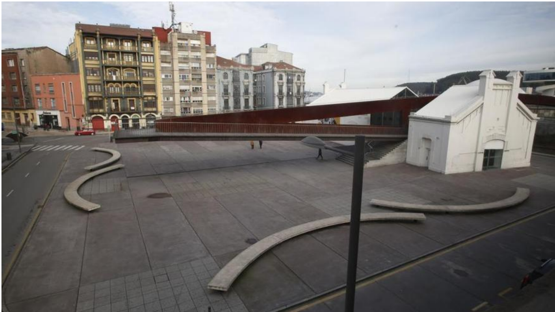
Figura 15. Vista de la estructura conocida como grapa una vez construida en la plaza de Avilés, interviniendo así en la antigua pescadería.
