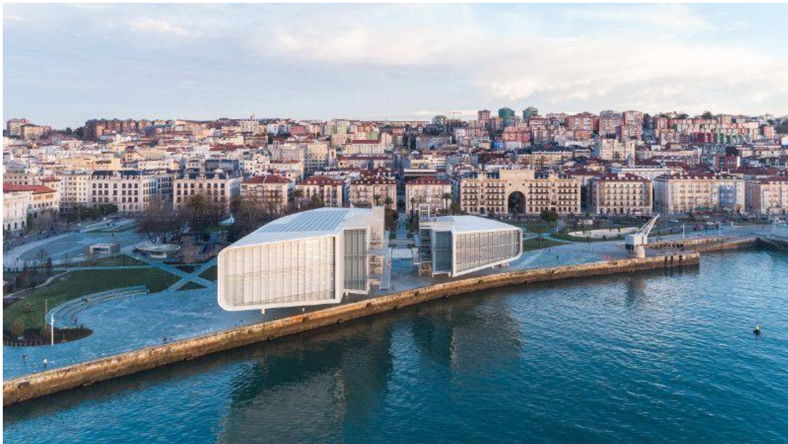
Figura 11. Vista aérea del enclave del Centro Botín en muestra de la unión entre el centro de la ciudad y la bahía.
