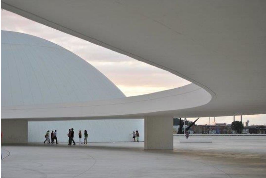
Fig. 20. Vista de la marquesina que sirve como unión y transición entre el Auditorio y la Sala de exposiciones.
