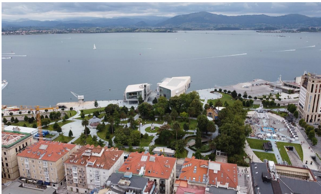
Figura 34. Vista aérea en fusión del casco urbano, los Jardines de Pereda y el Centro Botín, quedando este ultimo en perfecta sintonía de consonancia.
