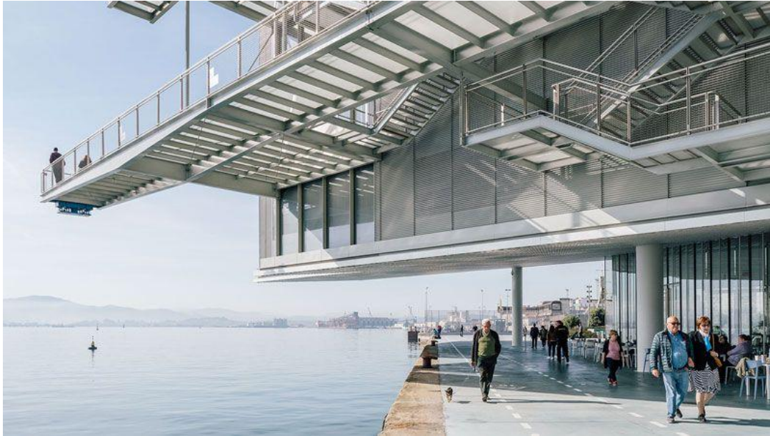
Figura 12. Vista en voladizo de parte de la estructura del Centro Botín.
