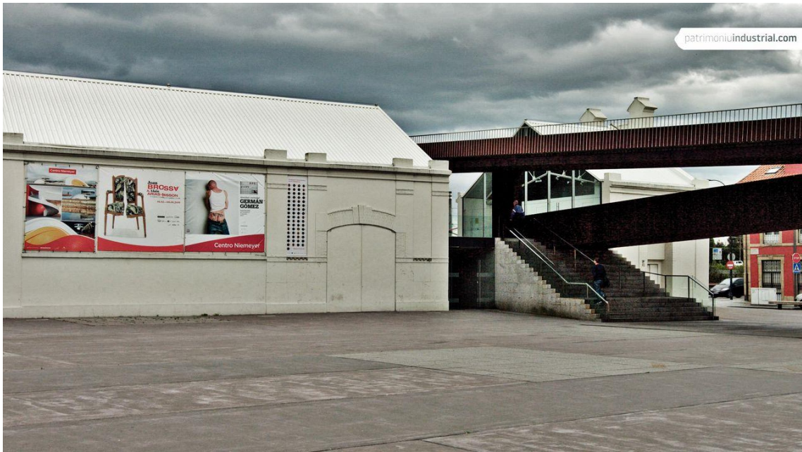
Figura 16. Vista de la intervención de la grapa en la antigua pescadería.
