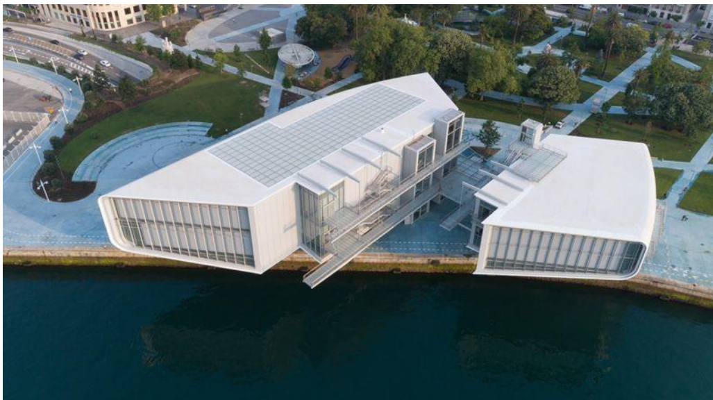
Figura 35. Vista en voladizo de la parte trasera del centro, observándose el cerramiento mediante fachadas de muro cortina además de la cubierta a modo de lucernario.
