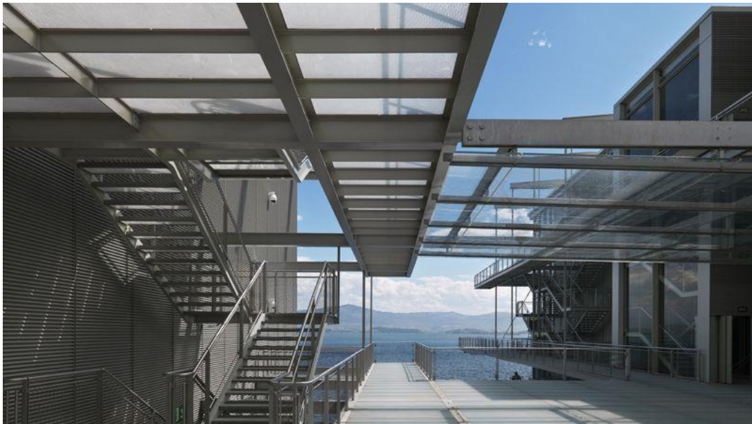
Figura 38. Entramado de pasarelas y escaleras verticales.
