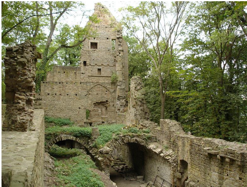
Fig. 5: Estado de ruina actual del Monasterio de Disibodenberg. Fuente: Wikipedia Commons.
