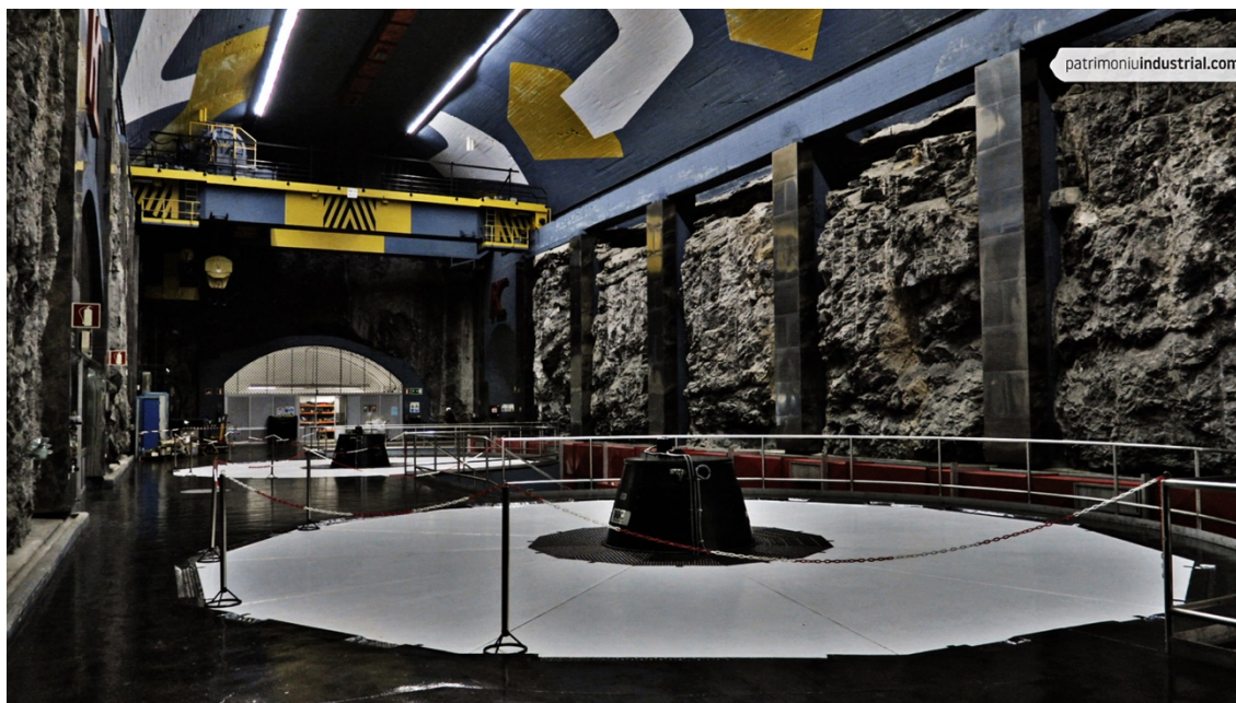
Fig. 7. Central de Tanes con los trabajos de integración artística a cargo de los Vaquero en paramentos y bóveda, generando un espectacular celaje. Fotografía: patrimoniuiindustrial.com
