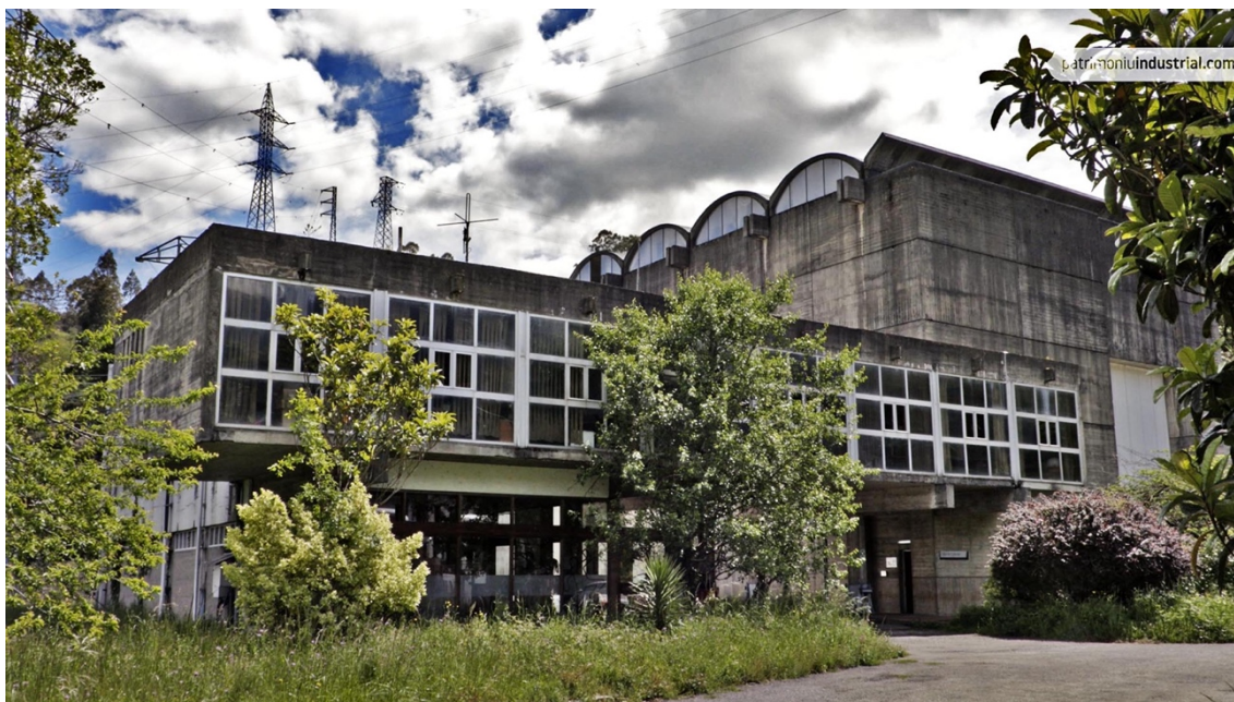
Fig. 12. Central de Arbón: la sinceridad constructiva, la modulación, el sugerente tratamiento de la luz y el cuidado diseño singularizan la labor de Castelao. Fotografía: patrimoniuiindustrial.com
