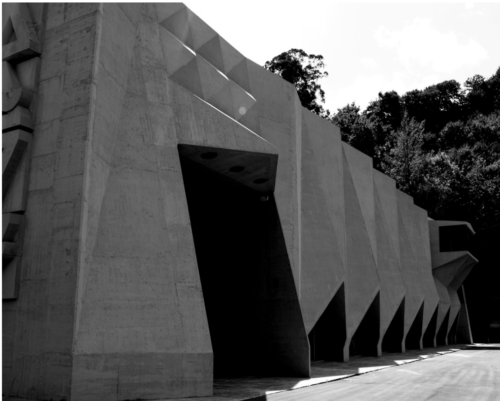
Fig. 5. Central de Proaza. Fachada definida por el tono brutalista de las aristadas facetas de hormigón. Fotografía de la autora.
