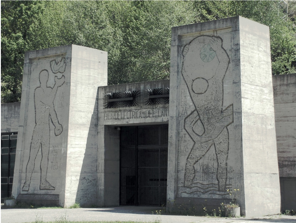
Fig. 4a. Ingreso a la central de Miranda. Bajorrelieves con la representación de Prometeo y Atlas en las chimeneas de ventilación que flanquean el acceso. Fotografía de la autora.
