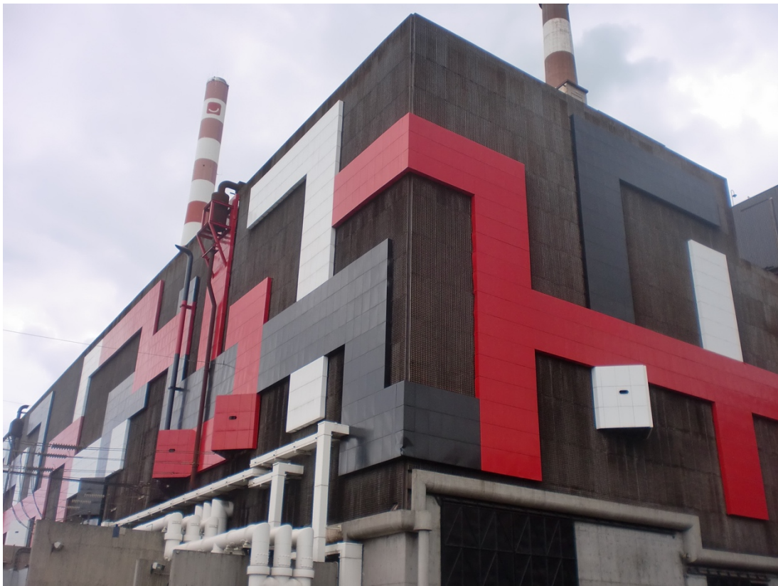
Fig. 8. Central térmica de Aboño. Ordenación estética del exterior a partir de ritmos y franjas cromáticas. Fotografía de la autora.
