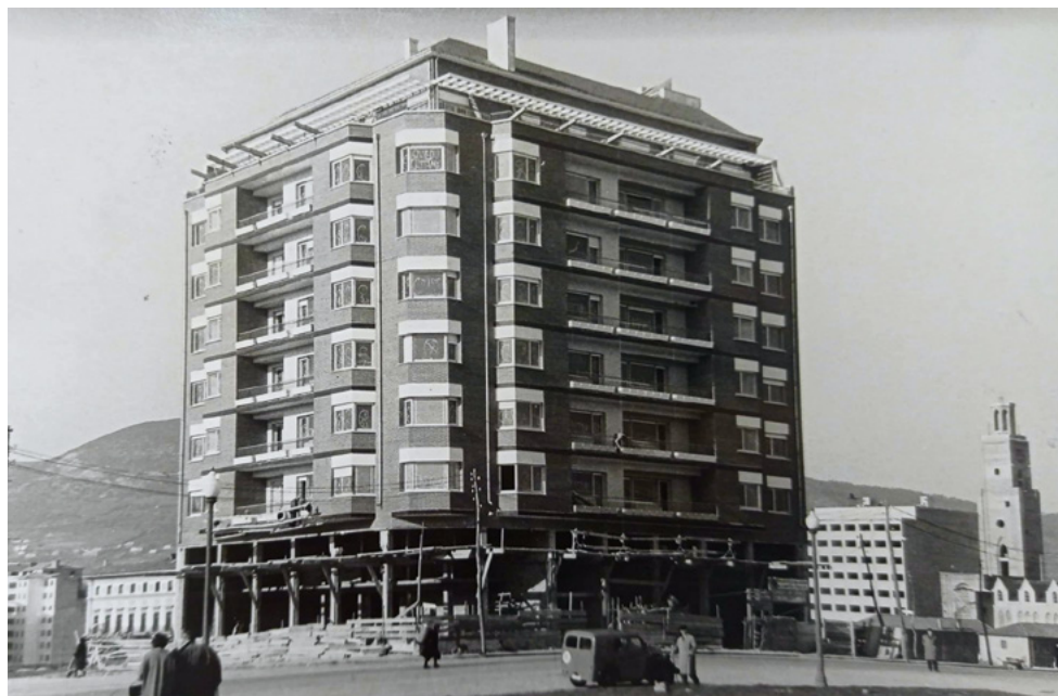
FIG. 6. Edificio en construcción de la Calle Calvo Sotelo en Oviedo proyectado por Julio Galán Gómez. Fuente: Archivo Julio Galán Gómez ©Museo de Bellas Artes de Asturias. Expediente 1724.
