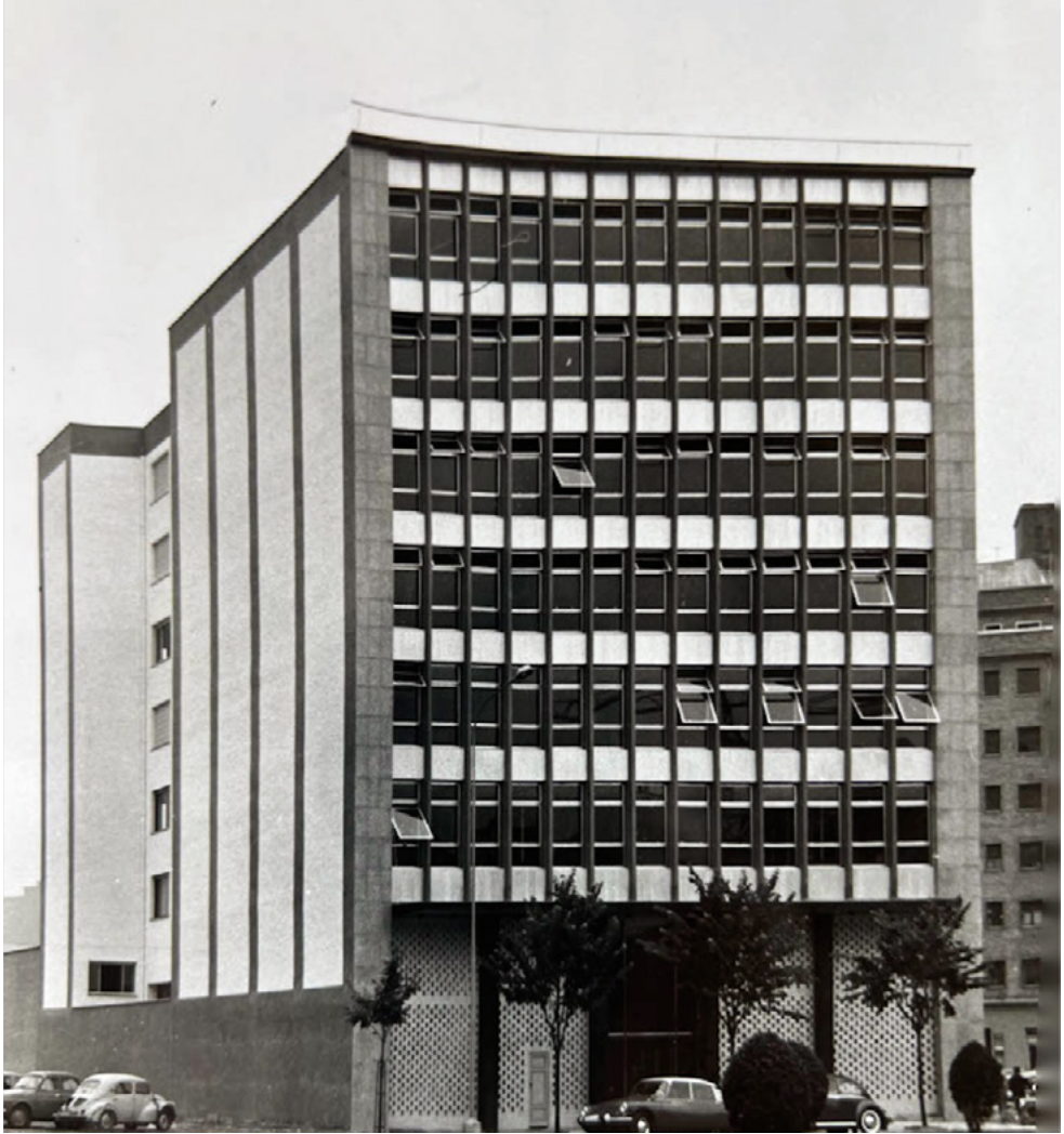
FIG. 8. Edificio para Colegios Profesionales de Asturias, popularmente Colegio de Médicos. h. 1968. Fuente: Archivo Julio Galán Gómez ©Museo de Bellas Artes de Asturias.
