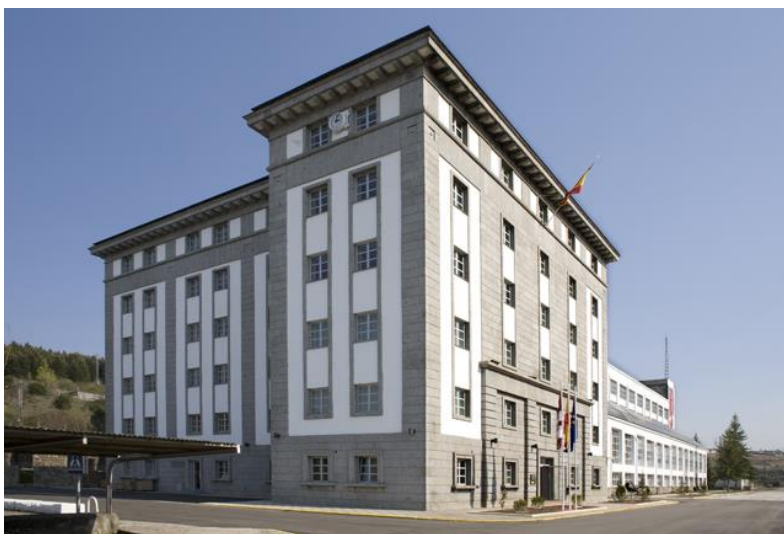
Figura 31. edificio de mandos de la Central térmica de Compostilla I. Fuente: Impulso, «Rehabilitación del edificio de mando de la C.T. de Compostilla I en Ponferrada, León», Impulso industrial alternativo S.A., accedido 3 de mayo de 2024, https://www.impulso.es/portfolio/rehabilitacion-del-edificio-de-mandos-de-la-central-termica-de-compostilla-i/
