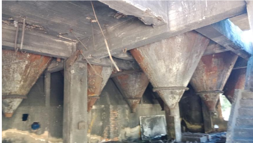
Figura 50. Estado actual de la planta baja en la zona de tolvas. 2022. Fuente: fotografía cedida por Julio Crespo García
