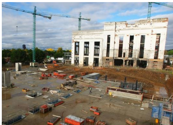
Figura 32. Inicio de las obras de rehabilitación. Autor: César Sánchez. Fuente: Violeta R. Oria, «Compostilla I, las tres vidas de un gigante», El Bierzo digital , 2019, https://www.elbierzodigital.com/trashed-11/273312
