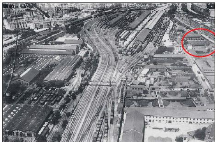
Figura 20. Ubicación de la Neomudéjar con el resto de las estructuras alrededor. Elio García, Francisco Martínez, y Germán Contreras, «Estudio patológico y proyecto de intervención, tomo I»
