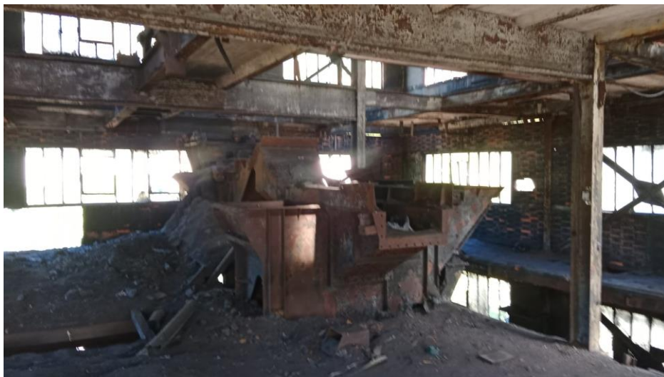
Figura 52. Interior de la cuarta planta, con la máquina todavía existente y los grandes huecos en el pavimento. 2022. Fuente: fotografía cedida por Julio Crespo García.
