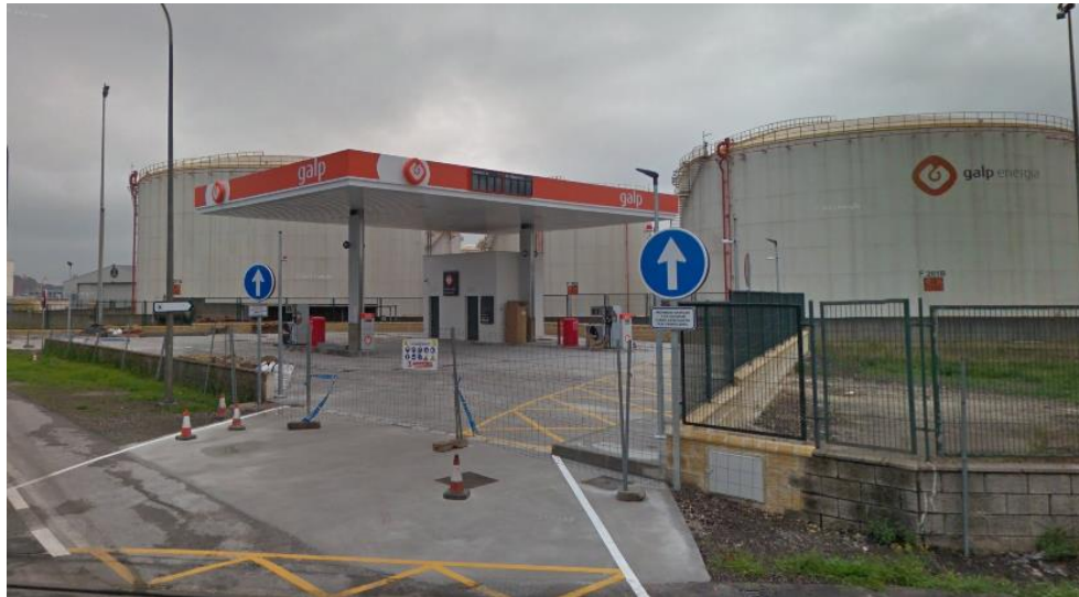
Ilustración 5.1. Estación de servicio durante su construcción.
