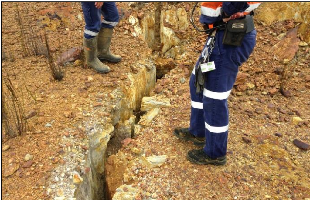
Figura 5.12. Formación de grietas asociadas a la zona de fracturamiento, debido a la subsidencia de una mina explotada por método de caving en Australia (Fernández, 2018).
