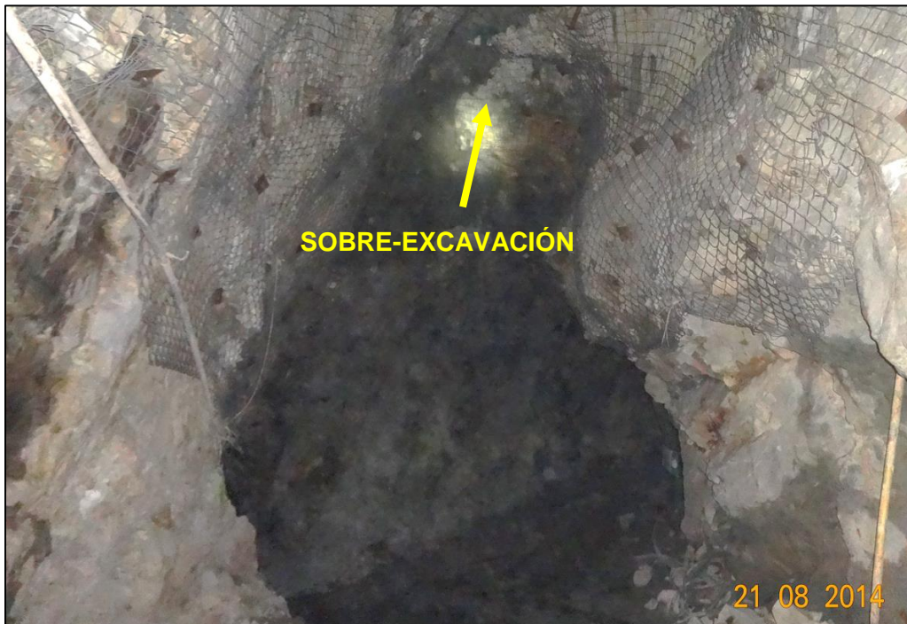
Figura 5.1. Sobre-excavación generada en la rampa de acceso de una mina subterránea, producto del desprendimiento de bloques en un sector de interacción de fallas y diaclasas (fotografía tomada por Fernández, 2021).
