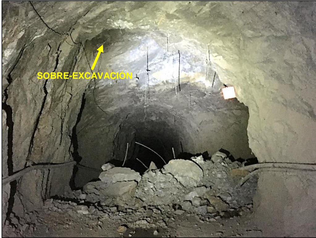
Figura 5.1. Sobre-excavación generada en la rampa de acceso de una mina subterránea, producto del desprendimiento de bloques en un sector de interacción de fallas y diaclasas (fotografía tomada por Fernández, 2021).
