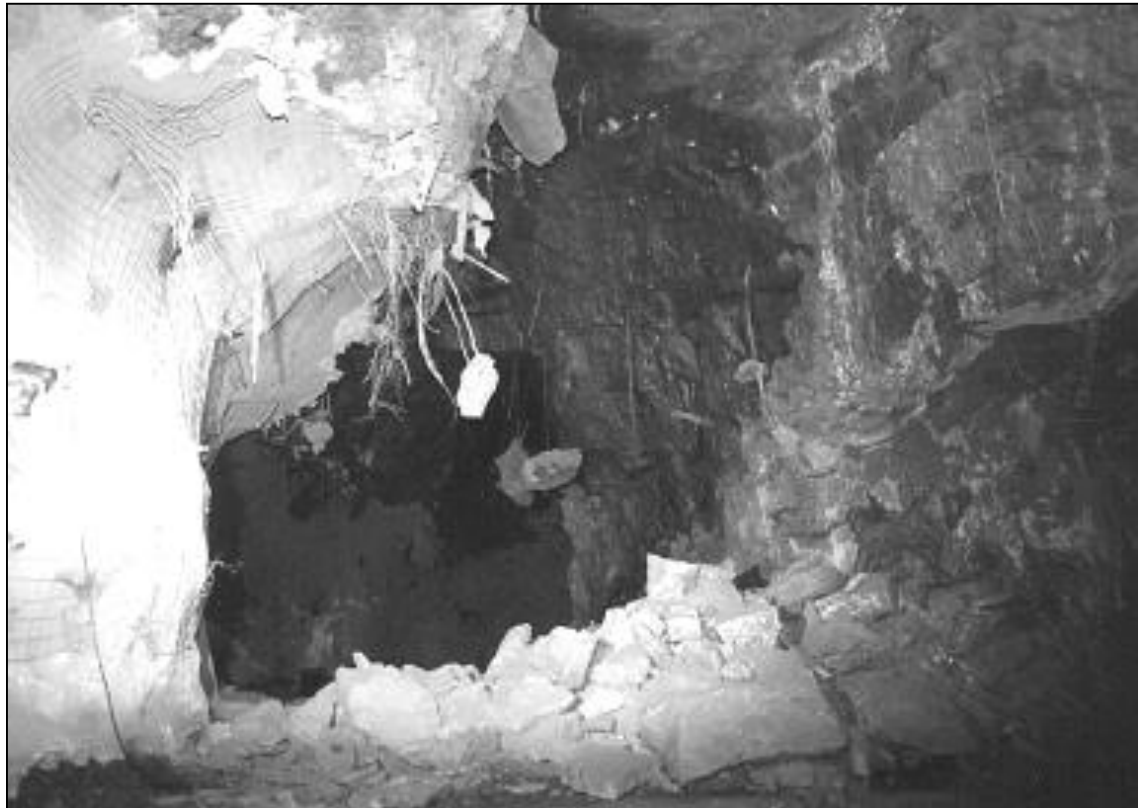
Figura 3.22. Eyección del material, asociada a condición de sismicidad inducida (Weber, 2007).
