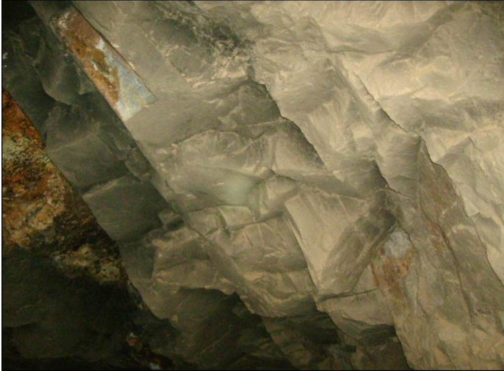
Figura 5.3. Formación de bloques definidos por diaclasas, en el techo de una galería subterránea (fotografía tomada por Fernández, 2018).
