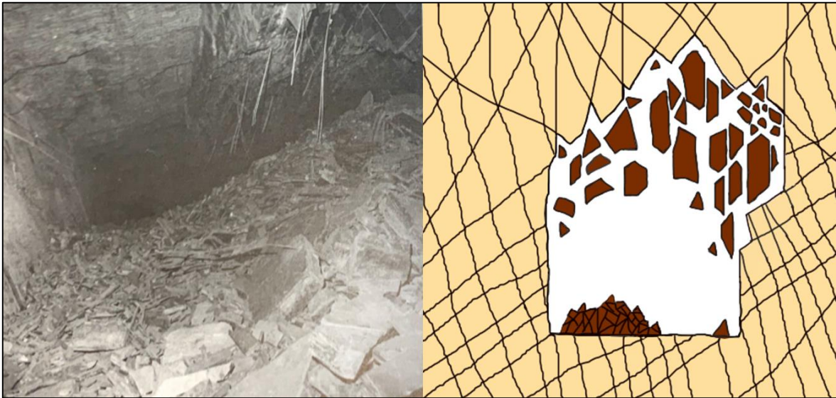
Figura 7.12. Reducción de esfuerzos en un macizo rocoso muy fracturado, causando una gran caída de bloques de diferentes tamaños (Potvin & Hadjigeorgiou, 2020)
