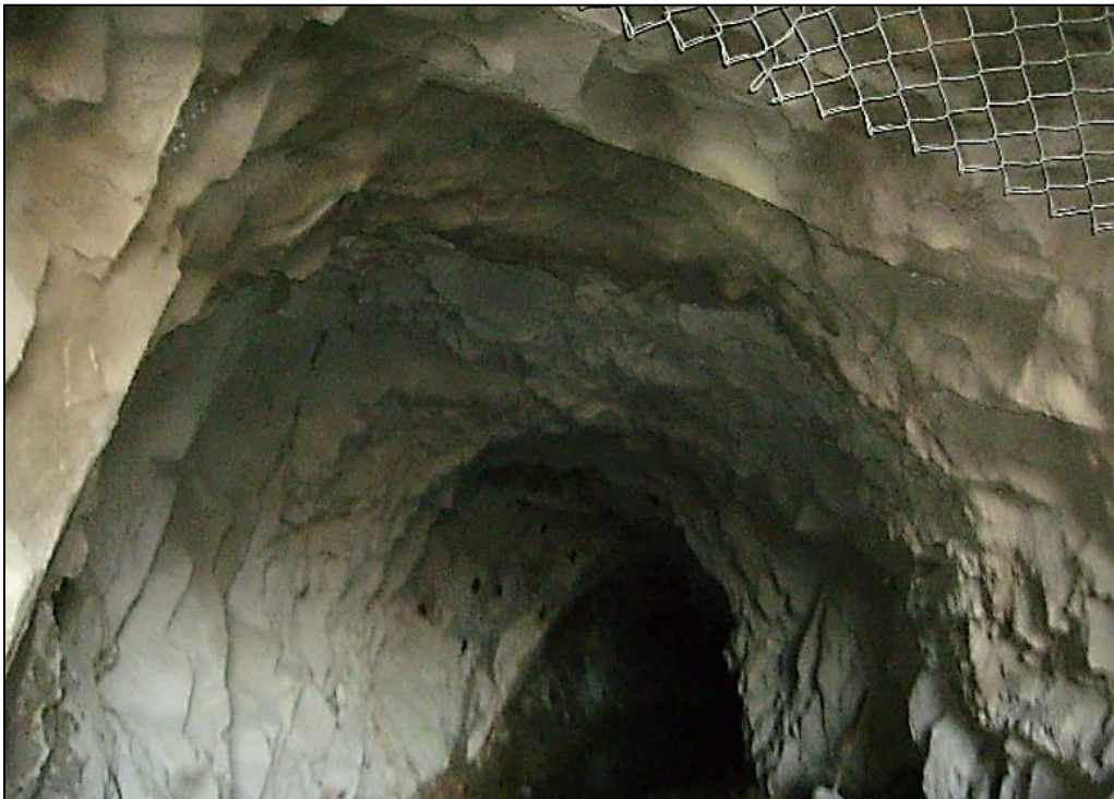
Figura 5.4. Definición de bloques formados por la interacción de diaclasas, en el contorno de una galería subterránea (fotografía tomada por Fernández, 2016).
