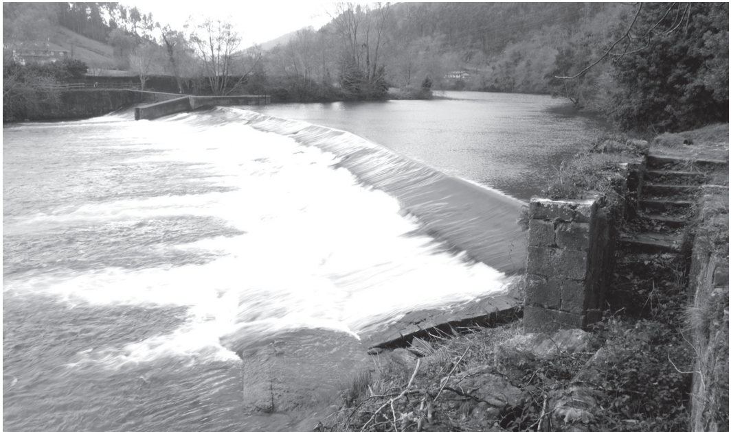
Figura 5 Presa de Marrón en la actualidad (fotografía de los autores)
