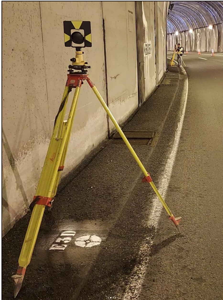
Figura 35. Fotografía de la ejecución de una poligonal en el interior de un túnel. Fuente: APGEO (Grupo EXCADE).
