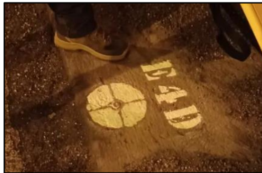
Figura 36. Señal de un GCP marcada con pintura. Fuente: APGEO (Grupo EXCADE).
