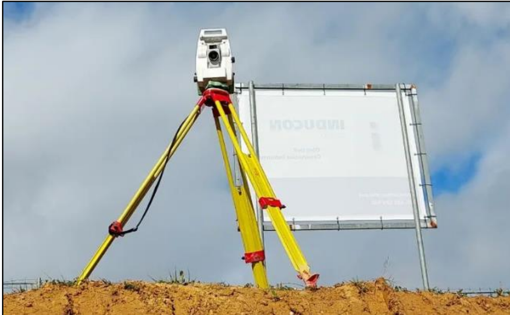
Figura 15. Estación total estacionada en trípode. Fuente: APGEO (Grupo EXCADE).
