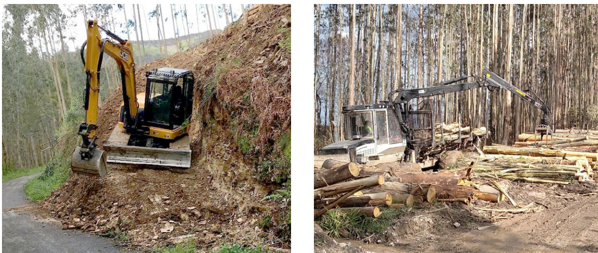
Figura CP11.7. Apertura de pista para el acceso del autocargador (izquierda) y ubicación de un cargadero a borde de pista (Fotos: Maderas Maradona (izquierda) y E. García Coya (derecha)).
