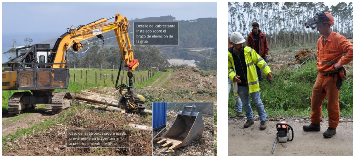
Figura CPIII.10. Máquina retroexcavadora de cadenas adaptada para el trabajo forestal y dotada de cabezal cosechador en punta de grúa (izquierda). A la derecha, motoserrista dotado de motosierra y equipo de protección individual (Fotos: M. Barrio Anta).
