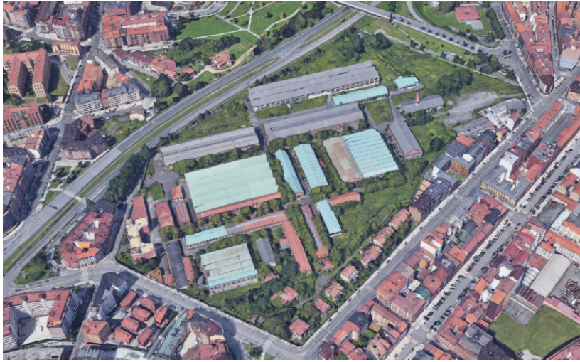
Figura 4: Estado actual del recinto de la Fábrica de Armas de La Vega.
