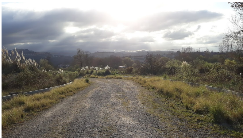
Figura 14: Estado del ámbito de suelo urbanizable de La Lloral
