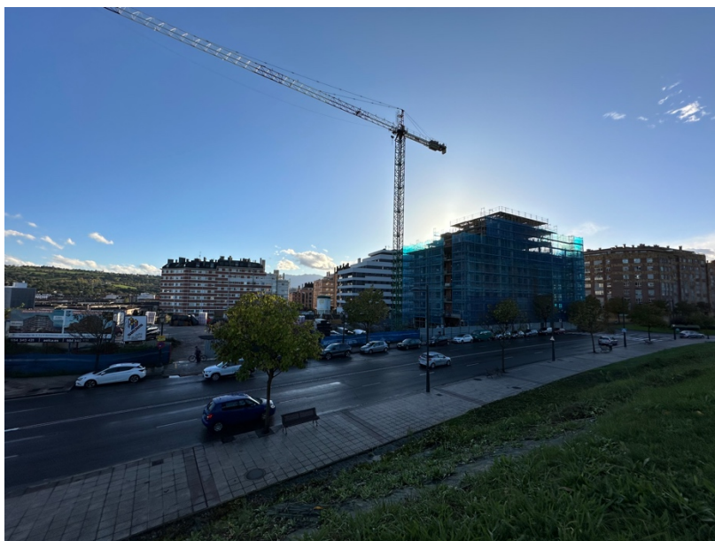
Figura 2. Viviendas en construcción en la última parcela de El Rubín
