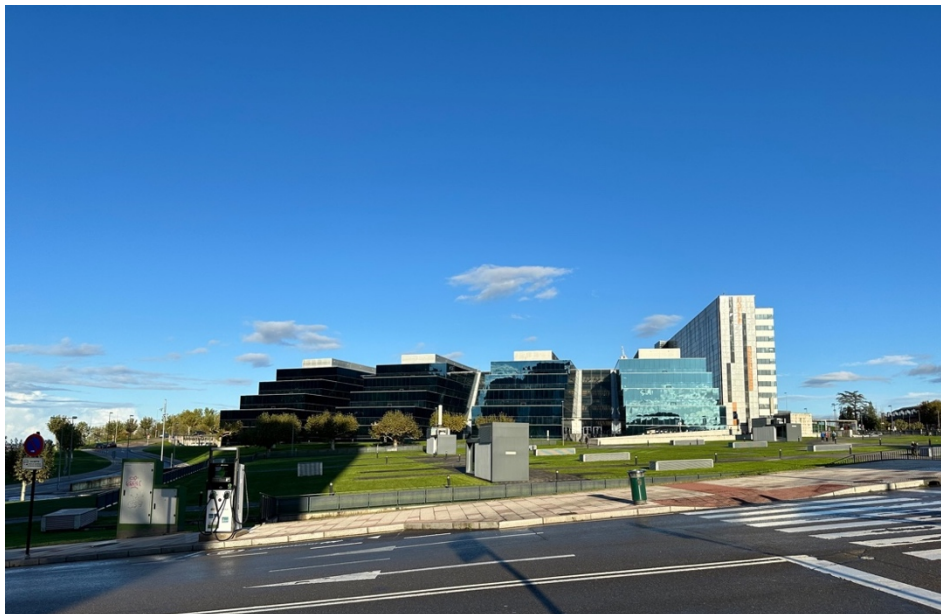
Figura 11. Imagen exterior del Nuevo HUCA
