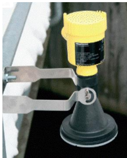
Ilustración 45. Instalación del transmisor de nivel tipo radar
