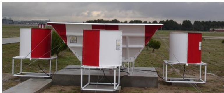
Ilustración 32. Perfilador y sistema RASS desplegados por AEMET en el aeropuerto de Madrid-Barajas [27]
