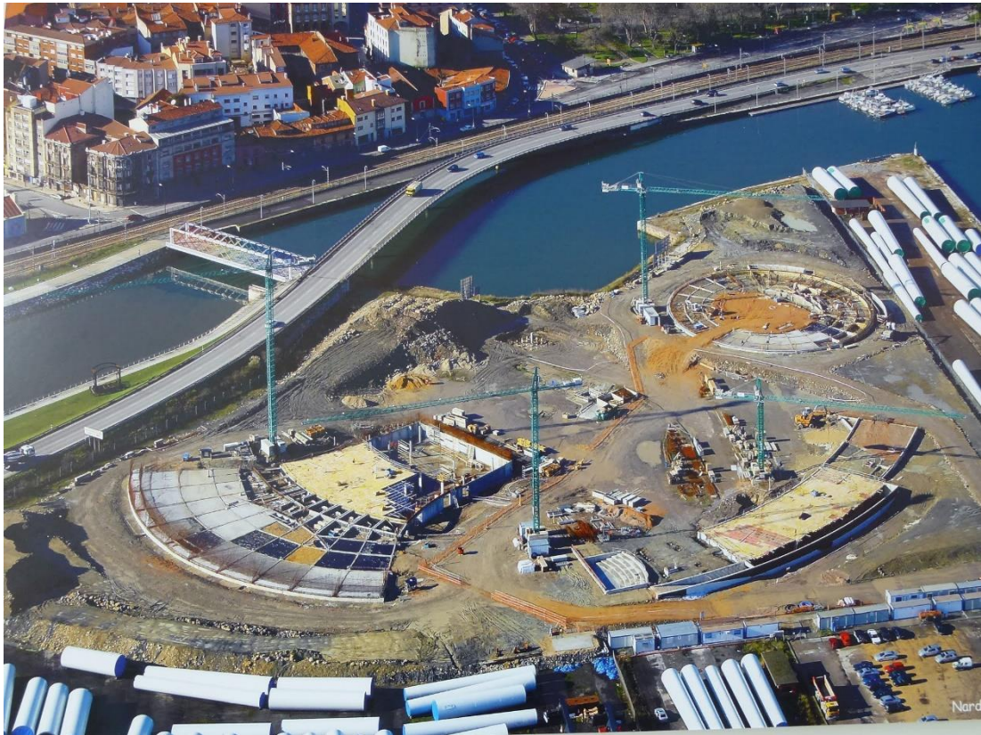
Ilustración 4.2 Centro Niemeyer en fase de construcción 3
