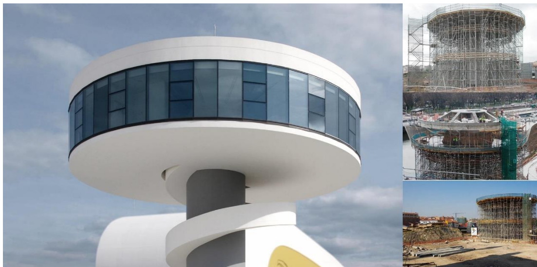
Ilustración 4.4 Edificio “Torre-Mirador” del centro Óscar Niemeyer 5
