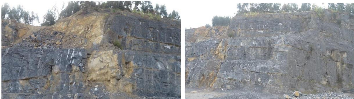
**Figura 18.** Aspecto de una de las fallas principales que afecta a los bancos de la explotación.
