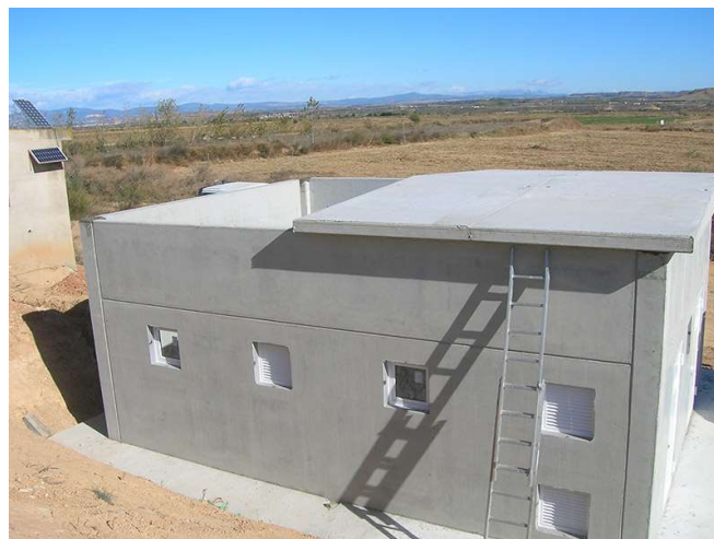
Figura 40. Caseta de control de hormigón prefabricada[46].
