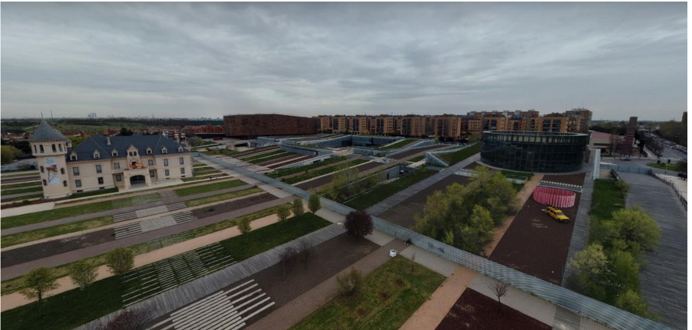
Ilustración 11. Vista del castillo de Valderas y a la derecha las instalaciones del CREA A cerradas al público. Fuente: Ángel Saguar - Google Maps 2023
