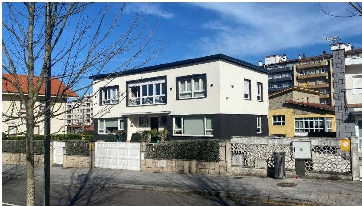
Ilustración 22. Vivienda sobre la que se realiza la instalación.
