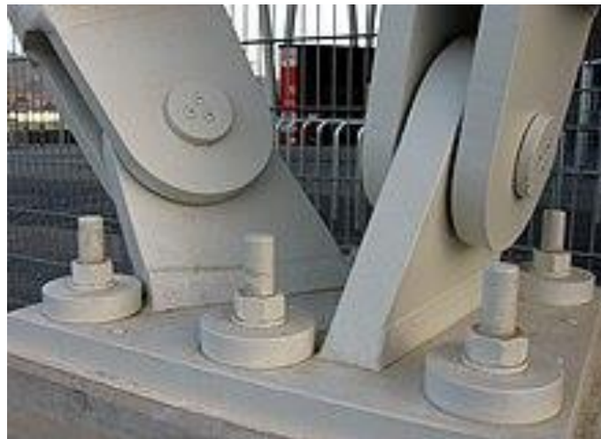
Figura 23.- Unión articulada en un puente
