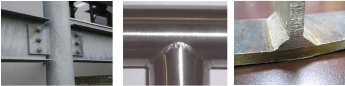
Figura 4.- Uniones estructurales mecánicas
