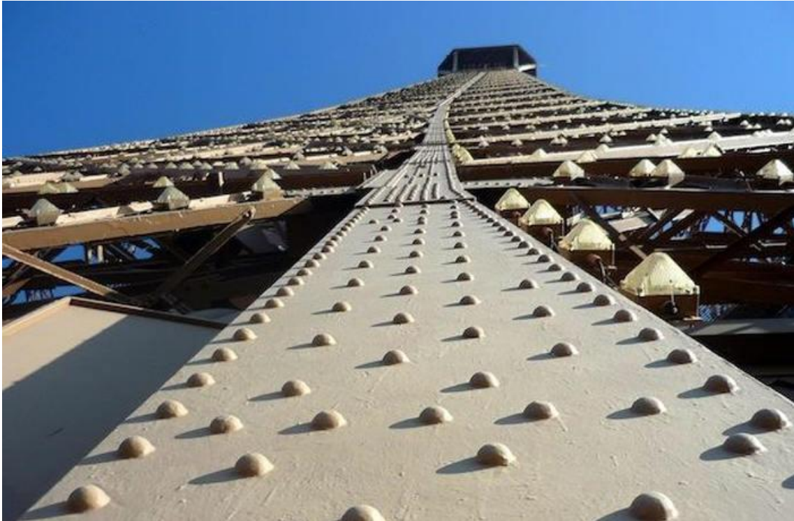
Figura 5.- Torre Eiffel donde se emplearon más de dos millones y medio de remaches.
