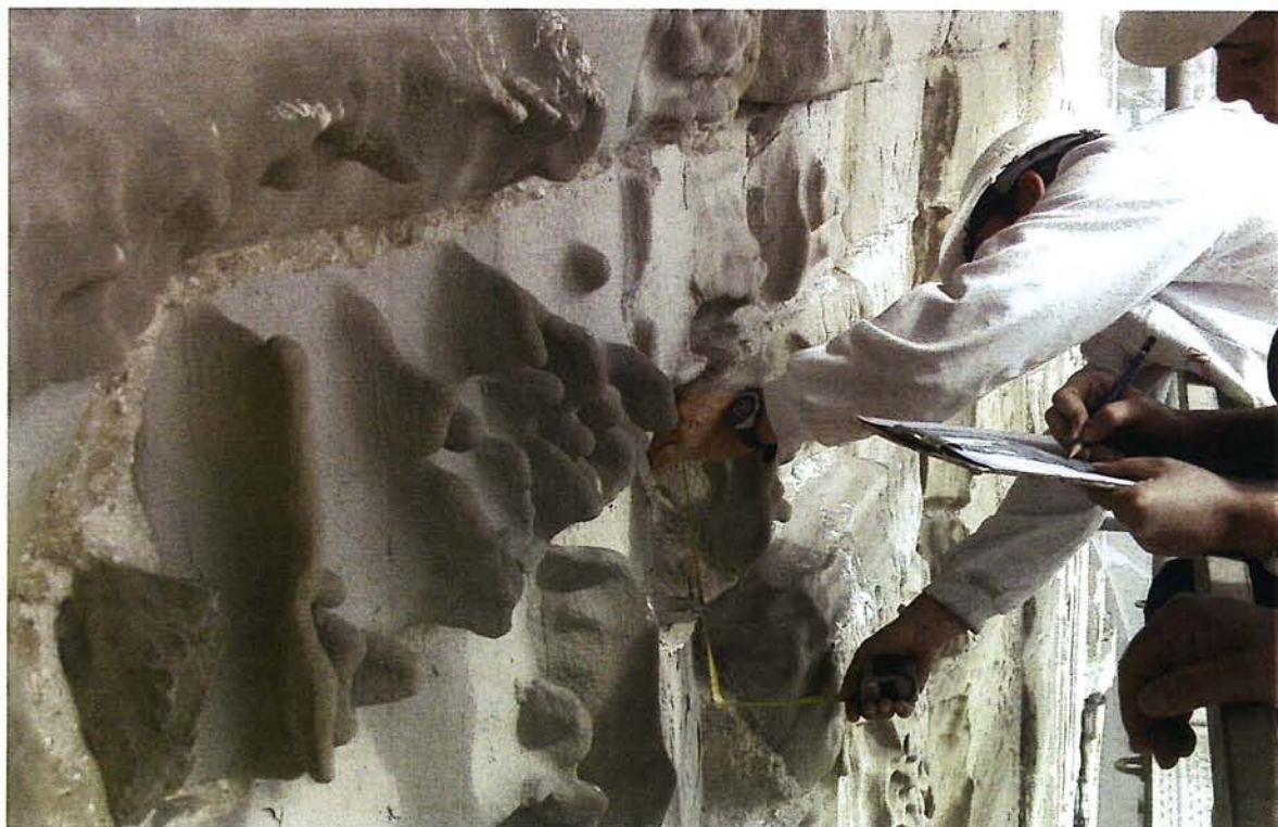
Figura 5: Evolución del fenómeno de alveolización hasta la pérdida de sección de los sillares. En estos casos sólo permanecen unas crestas de arenisca donde antes había un volumen continuo de la misma.
