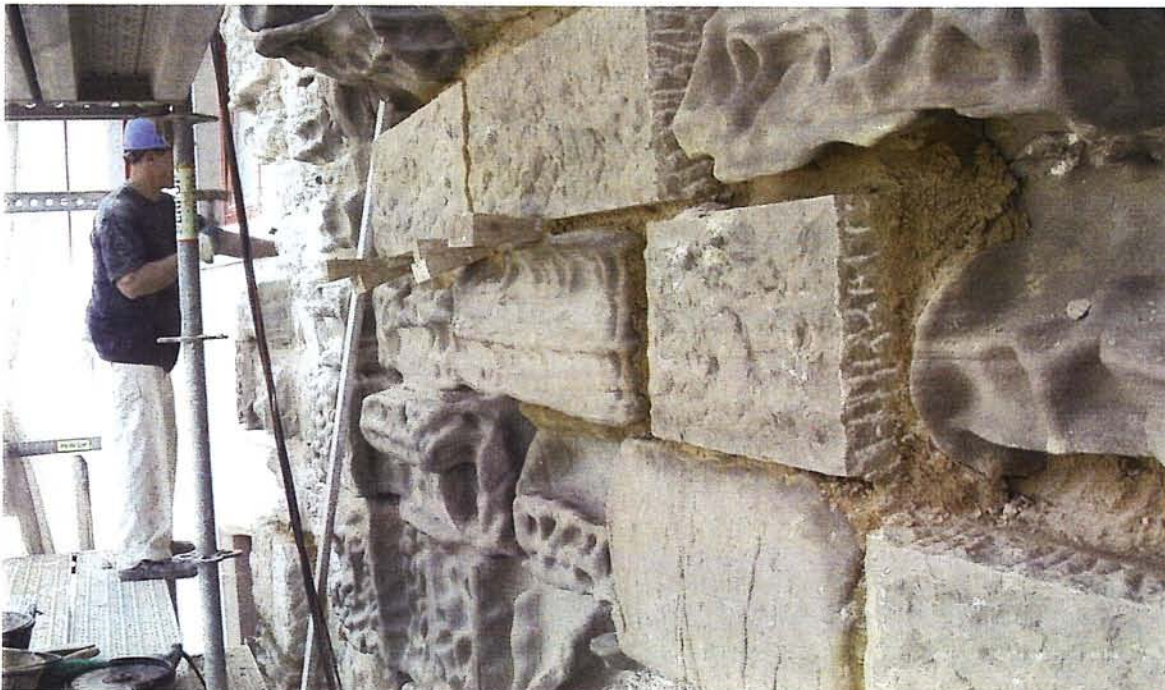
Figura 8: Labores de reposición con piedra en el cuerpo central de la capilla. Figure 8. Stone replacement in the central section of the chapel.
