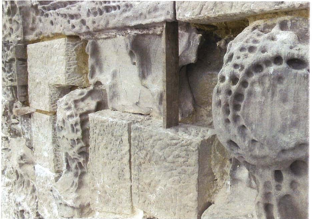
Figura 7: Labores de reposición con piedra. Figure 7. Stone replacement tasks.
