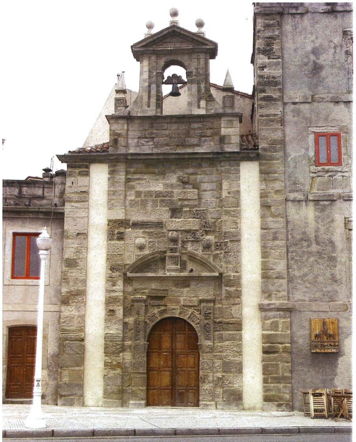
Figura 11: Aspecto general de la fachada después de la intervención. Figure 11. Overall appearance of the façade after the work.
