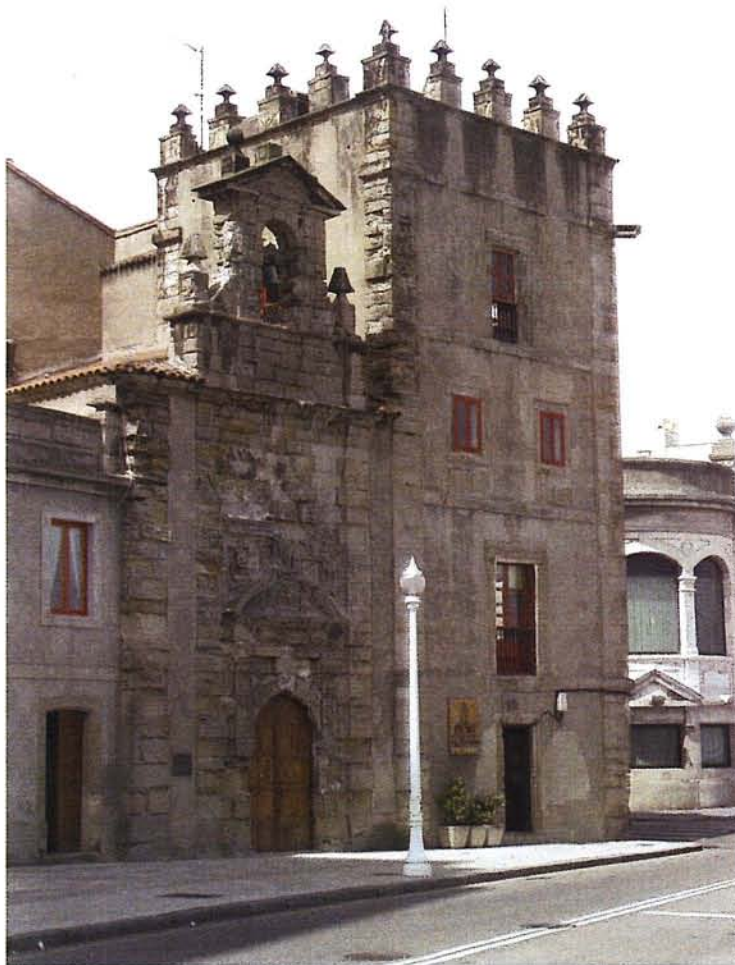
Figura 1: Aspecto general que presentaba la fachada de la capilla de San Lorenzo de Gijón antes de la intervención (Octubre 2002). Figure 1. Overall appearance of the façade of the Chapel of San Lorenzo in Gijón before the restoration. (October 2002).
