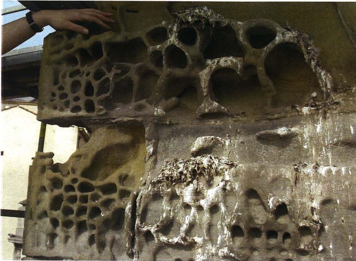
Figura 6: Sobre muchos de los alveolos se acumulan depósitos orgánicos de excrementos de aves. Figure 6. Bird excrement accumulates on many of the alveoles.
