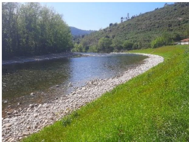
Figura 8. Estado general de la margen del tramo de Grullas del río Nalón (concejo de Candamo). Imagen propia.
