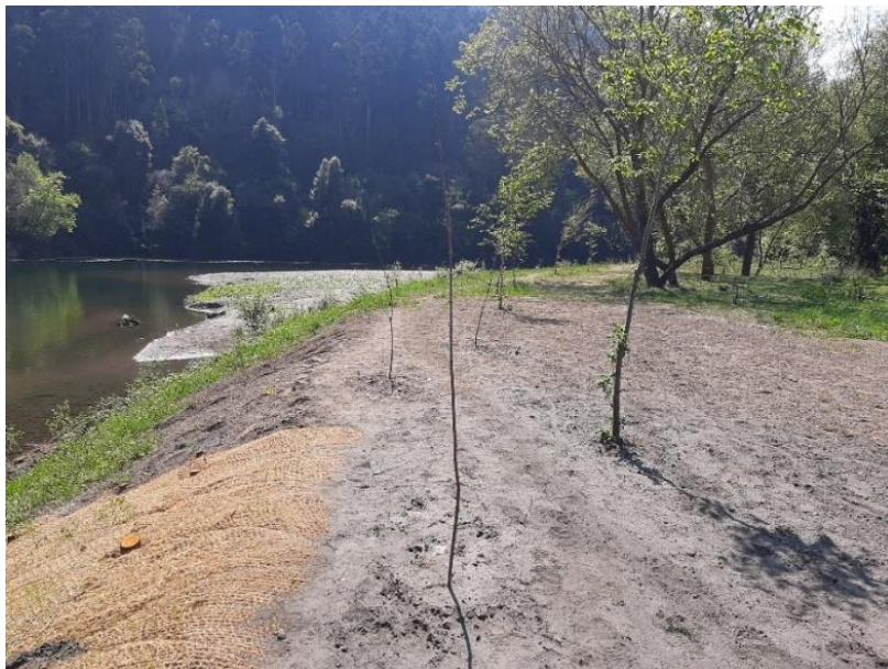
Figura 10. Plantación de árboles propios del bosque de ribera en el talud superior para su regeneración en el tramo de Forcinas (concejo de Pravia). Imagen propia.
