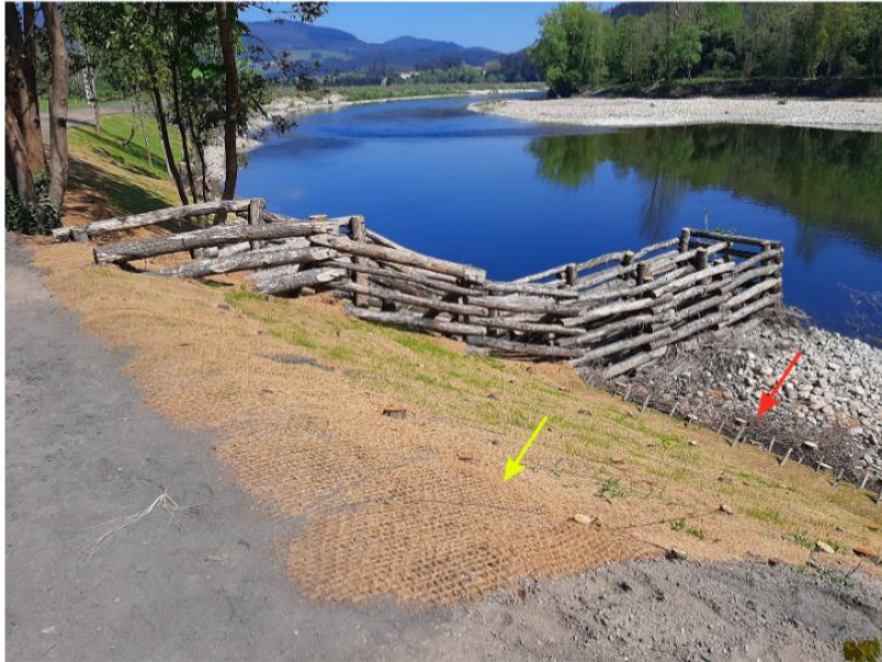
Figura 9. Técnica de bioingeniería para la estabilización de las márgenes fluviales mediante la implantación de una malla de coco (flecha amarilla) y la colocación de estaquillas de sauce (flecha roja) en el tramo de Forcinas (Pravia). Imagen propia editada con el programa de edición Canva.
