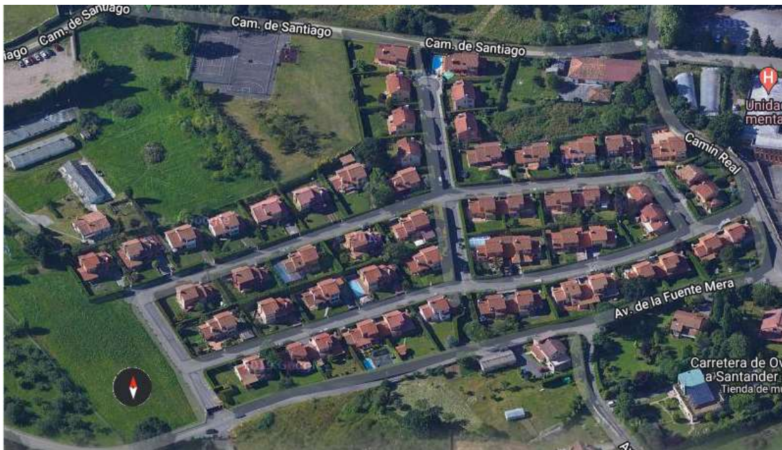
Imagen 4.1-Localización de las viviendas
