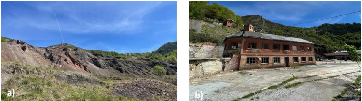
Figura 1.8: Aspecto de la escombrera de la antigua mina de La Soterraña (a) y de las instalaciones donde, entre otras labores, se realizaba la metalurgia (b).
