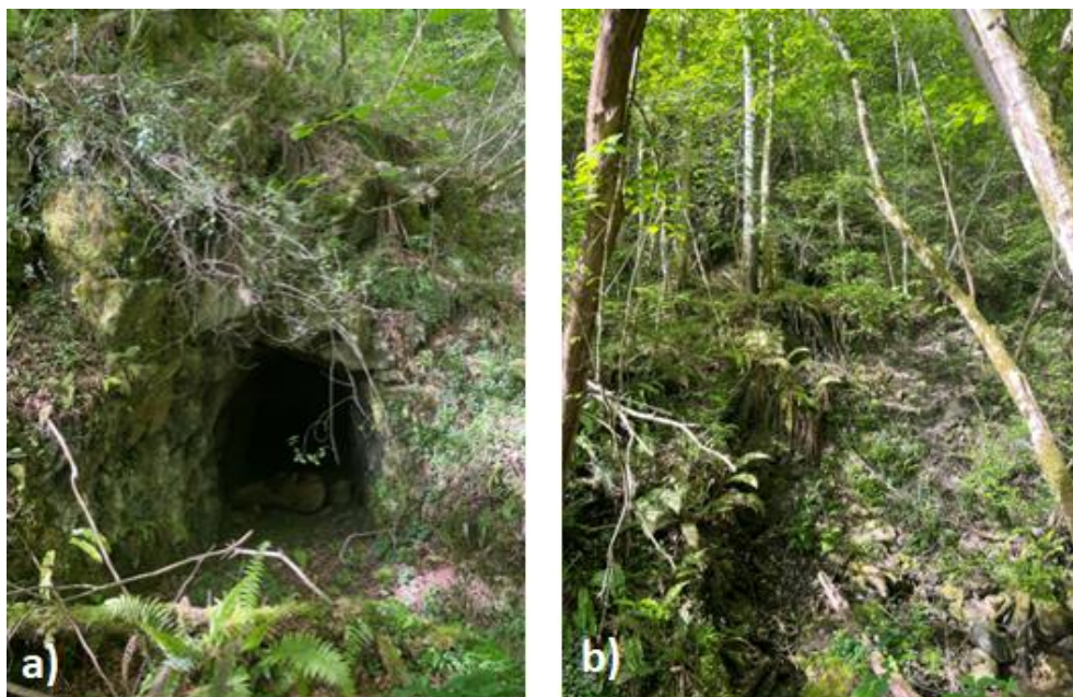
Figura 1.4: Entrada a la galería inferior de la mina (a) y escombrera junto al arroyo cubierta de vegetación (b).
