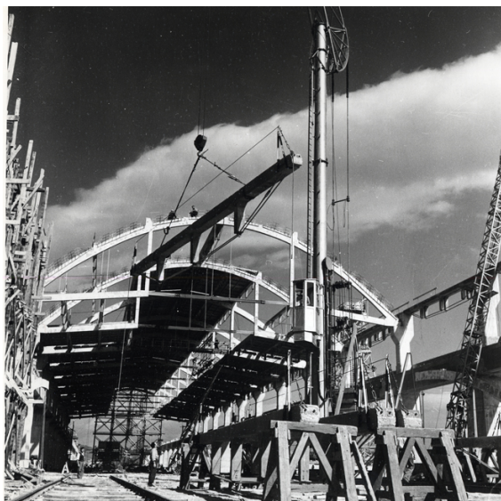
Figura 2: Montaje de los entramados horizontales.
