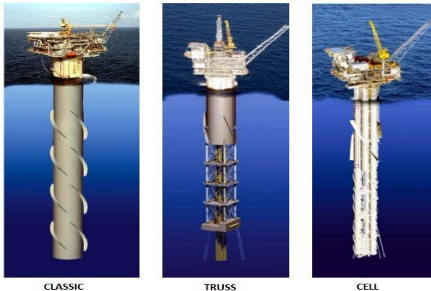
Figura 9. Ejemplos de plataformas SPAR
