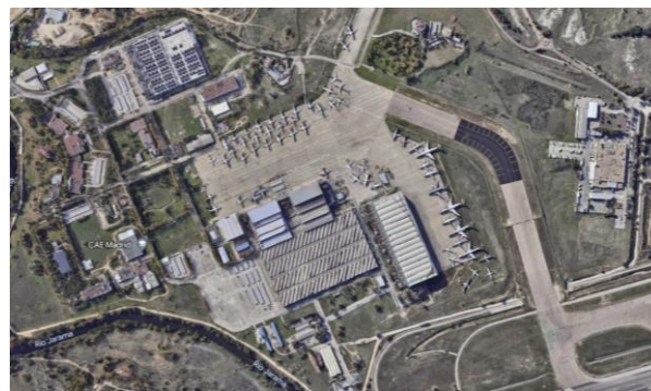
Ilustración 2 Centro de instrucción de Iberia Mantenimiento - La Muñeza
