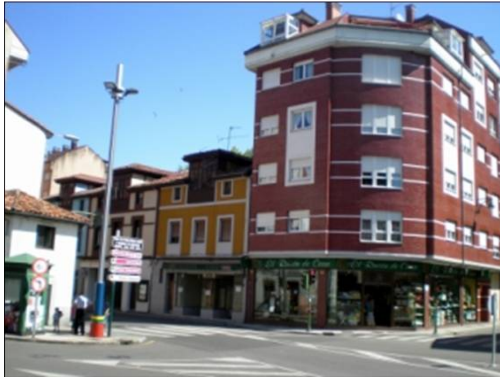
Figura 12. Sustitución de edificios en la carretera general, Sama de Langreo.
