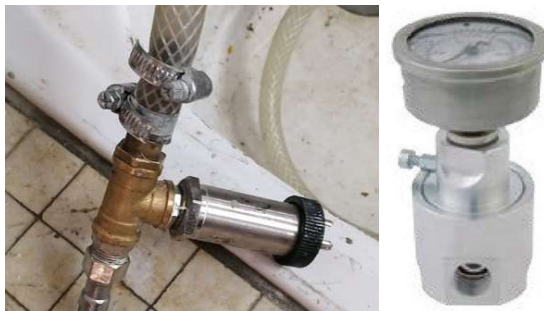
Figura 43. Sensor de presión y sistema de protección
