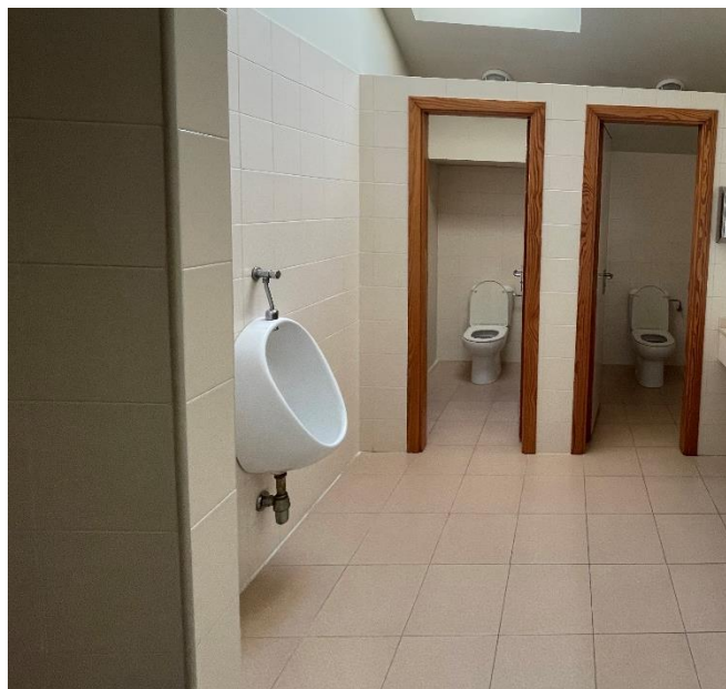
Figura 3.56 Fotografía de un baño de hombres de la tercera planta
