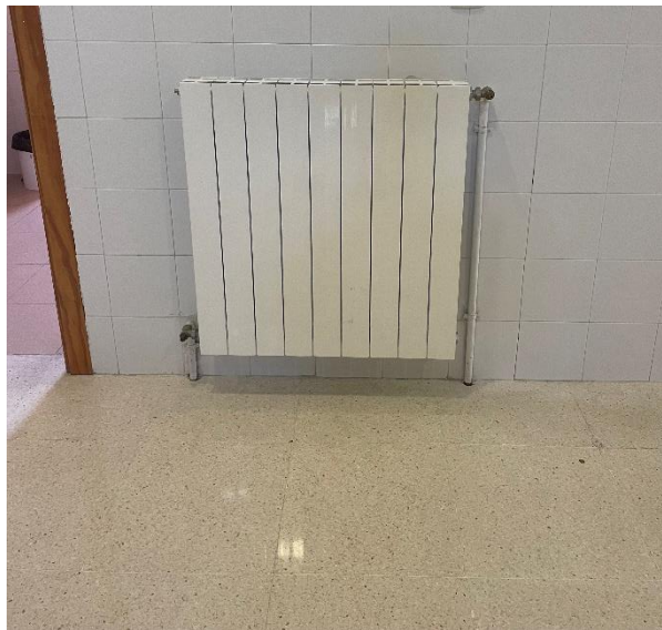
Figura 3.46 Fotografía de radiador con toma superior de suministro e inferior de retorno de agua
